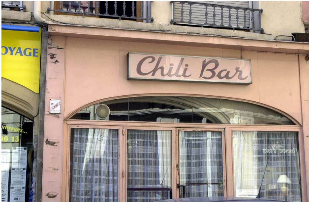
Façade, détail de la boutique de droite
