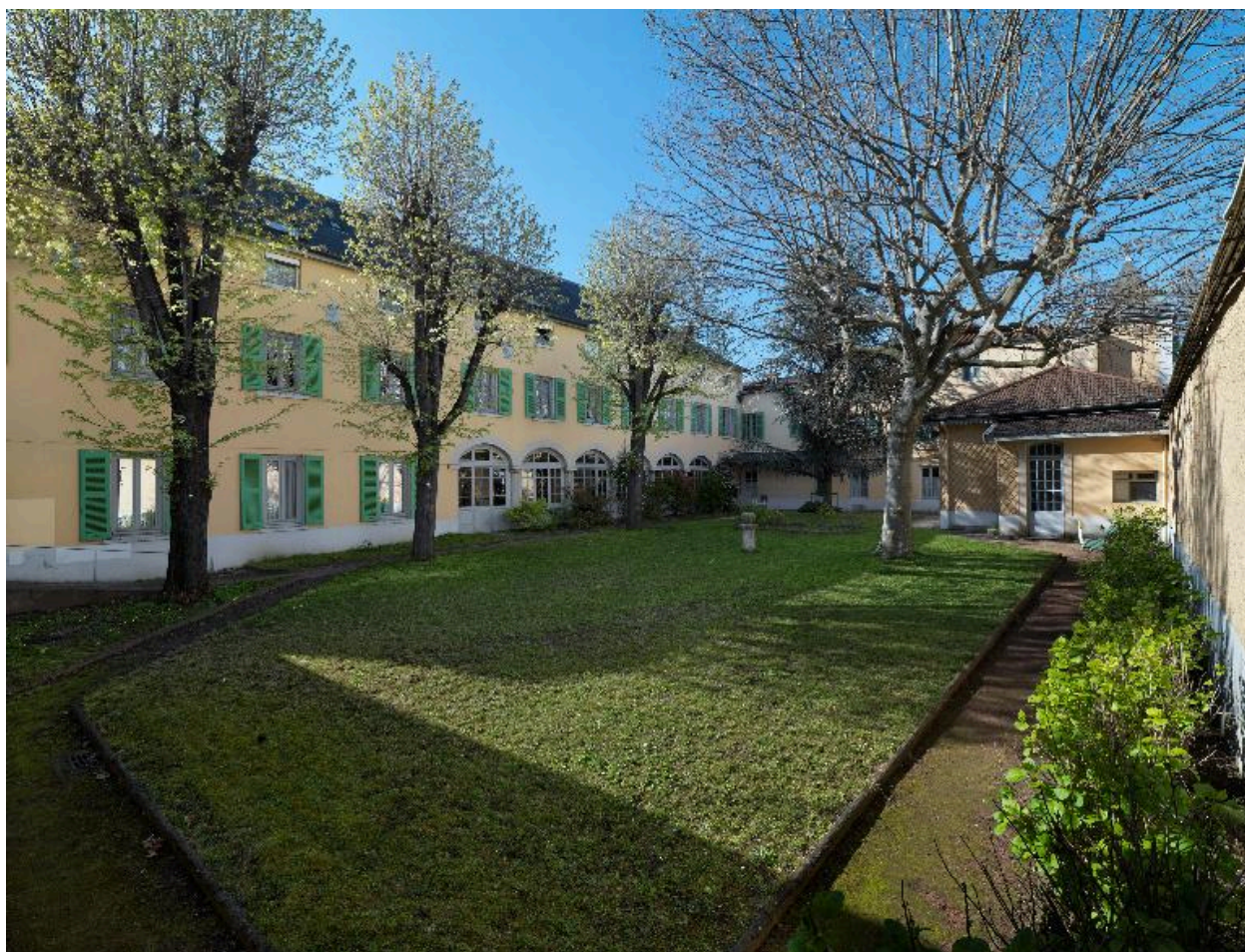
Cour sud-est, vue générale
