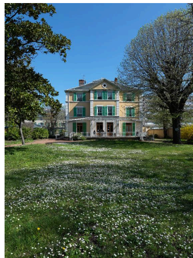
Villa du Parc : élévation ouest Phot. Thierry Leroy IVR84_20176901165NUCAQ
