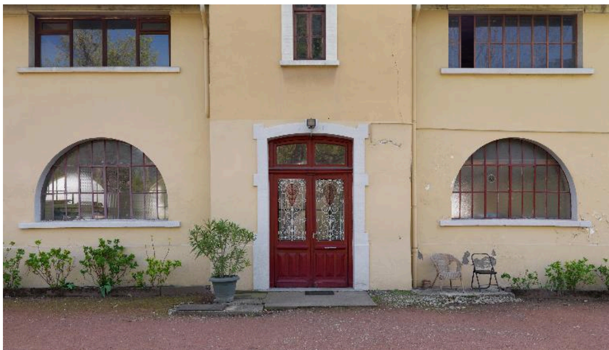
Château d'eau : détail de l'entrée
