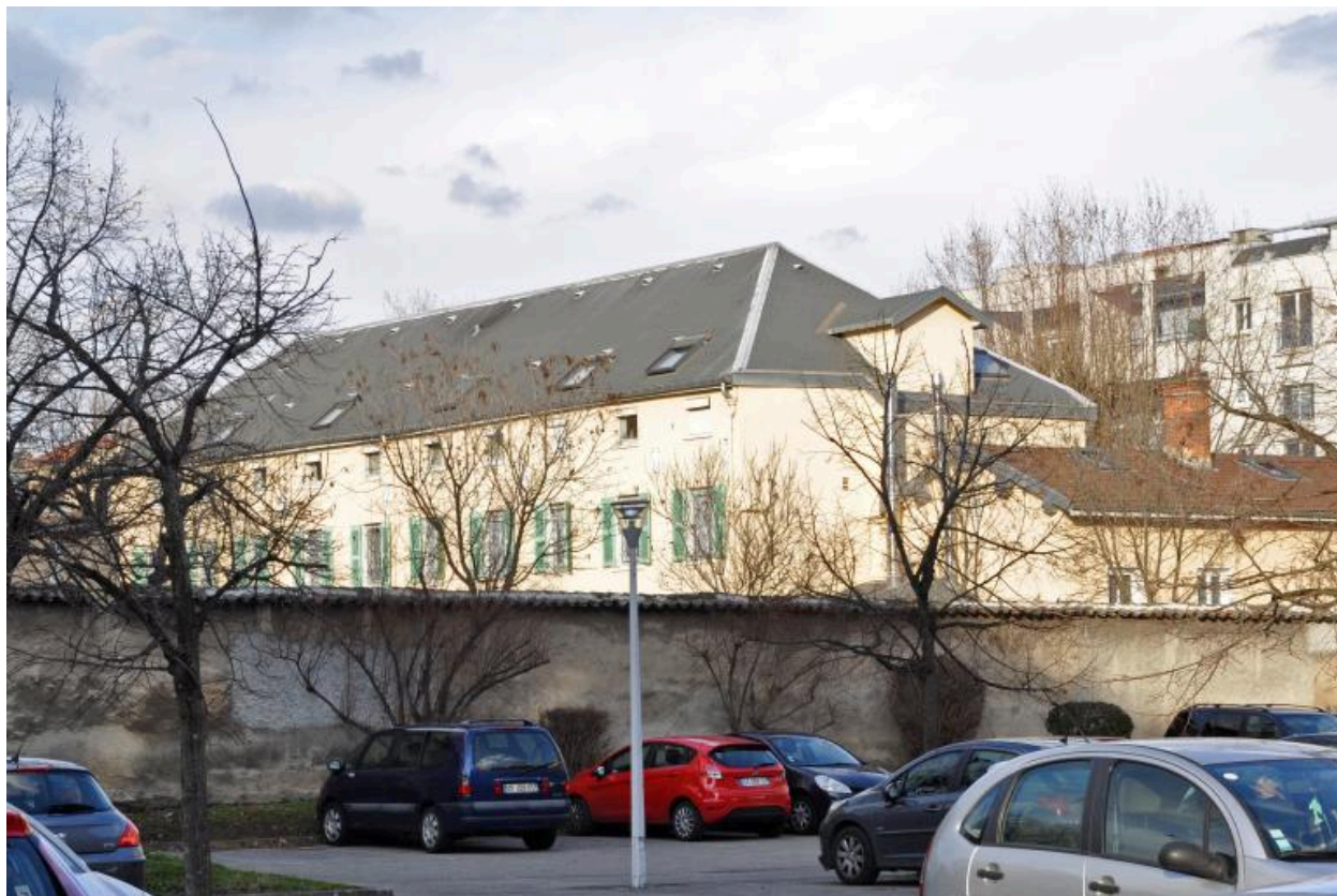
Aile sud, vue partielle de l'élévation postérieure
