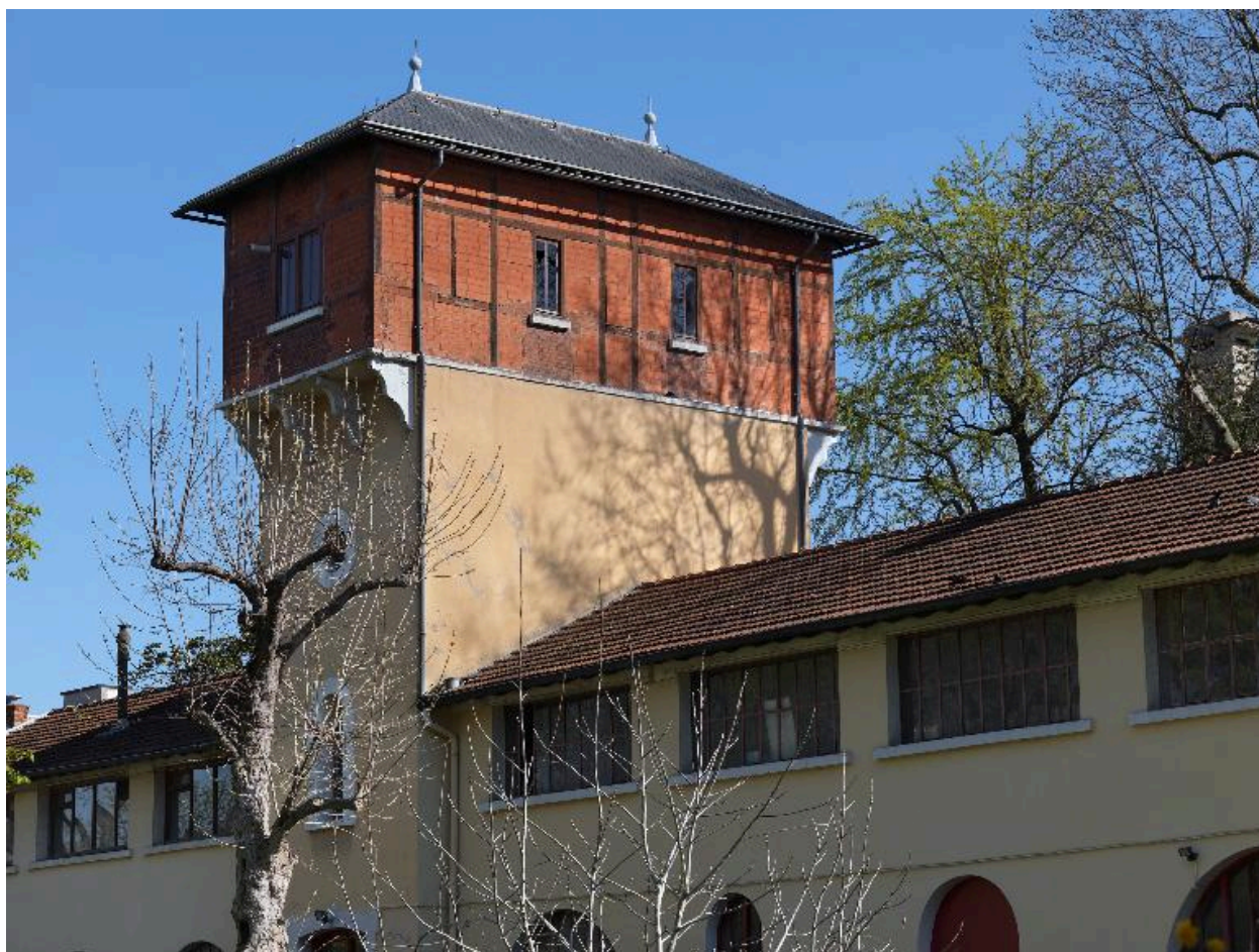
Château d'eau : détail des parties hautes
