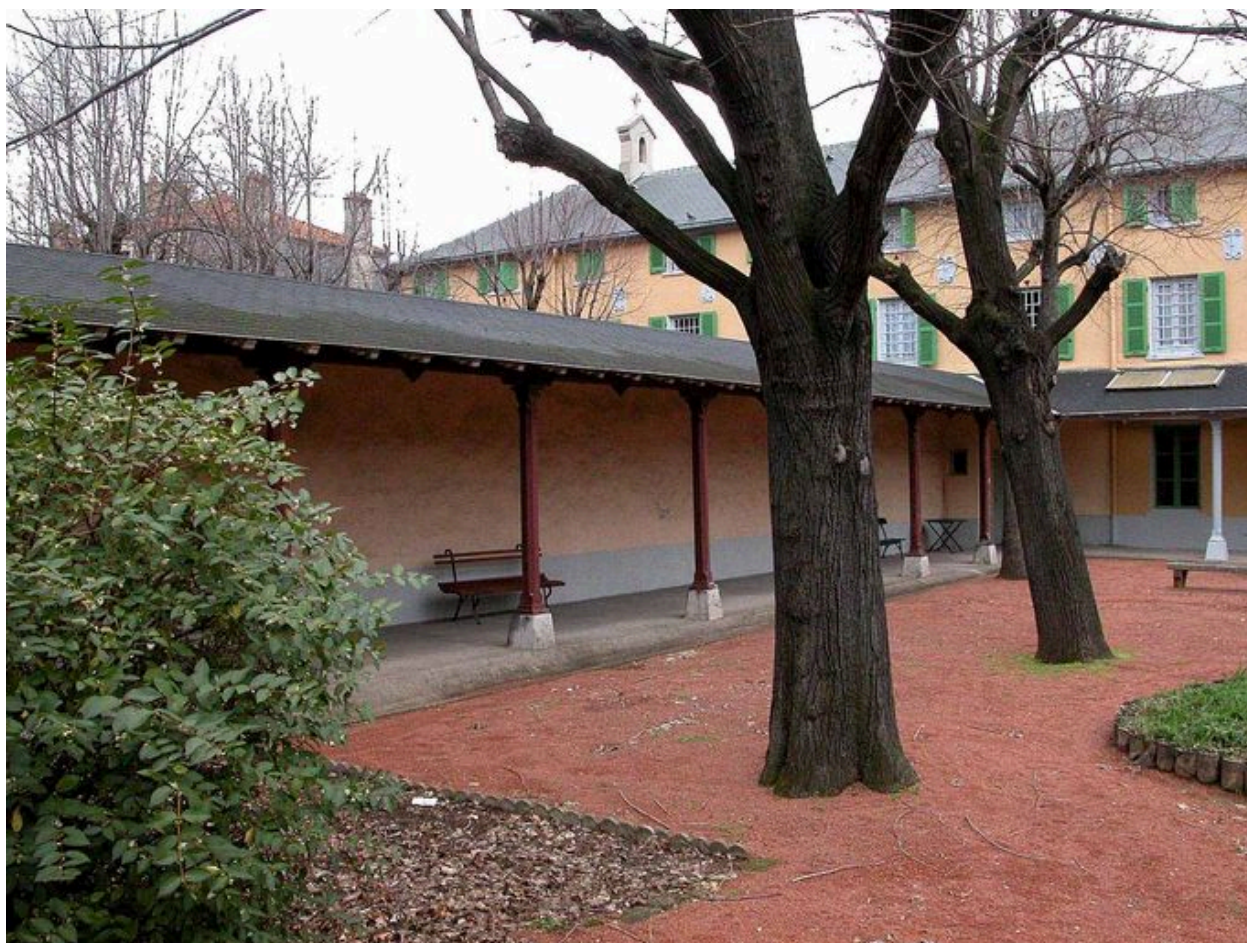
Cour nord-ouest, vue des portiques avant remaniement
