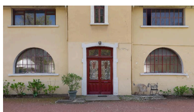
Château d'eau : détail de l'entrée Phot. Thierry Leroy IVR84_20176901160NUCAQ
