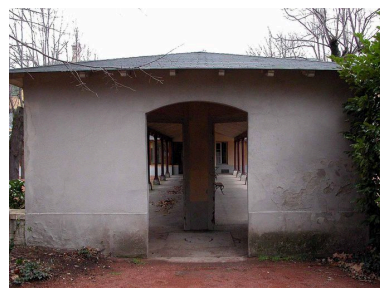
Cour nord-ouest, porche d'entrée commun aux deux portiques mitoyens, côté ouest (vue avant remaniement) Phot. Véronique Belle IVR82_20046901018NUCA
