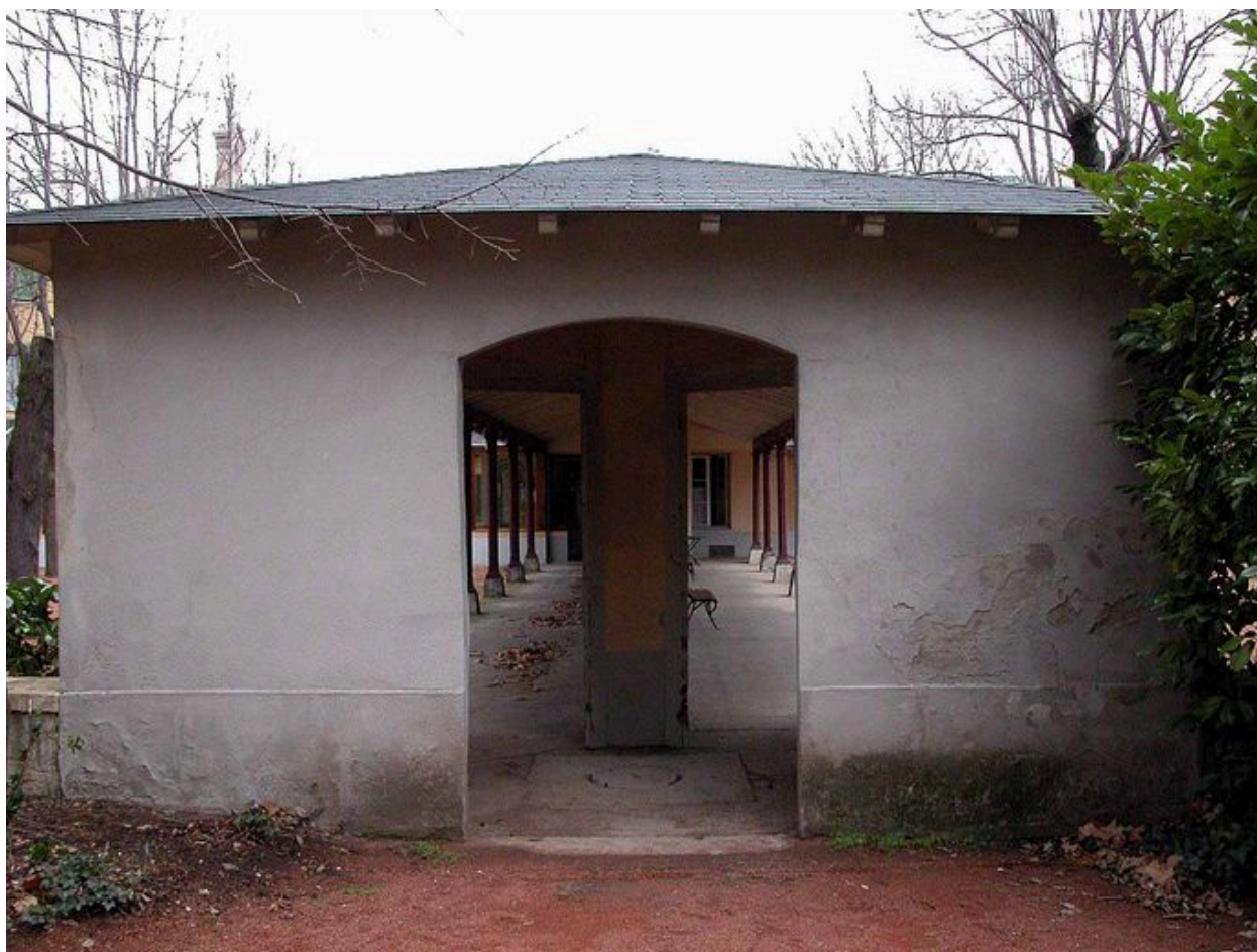
Cour nord-ouest, porche d'entrée commun aux deux portiques mitoyens, côté ouest (vue avant remaniement)
