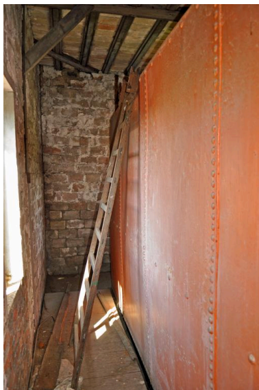
Château d'eau, vue intérieure : la cuve en fonte rivetée Phot. Magali Delavenne IVR84_20186901058NUCA
