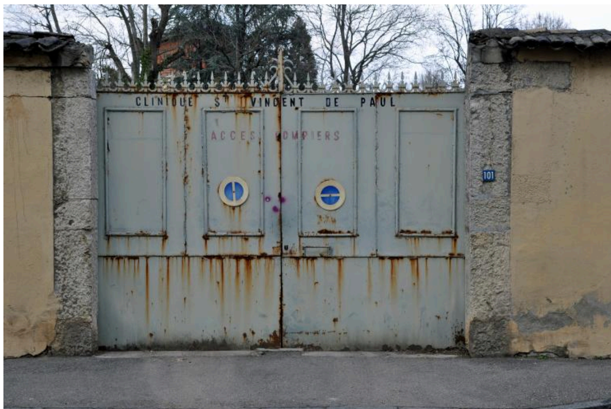
Portail donnant accès au parc et bâtiments techniques, au 101 rue de Montagny
