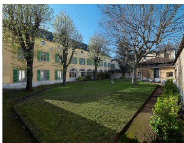
Cour sud-est, vue générale Phot. Thierry Leroy IVR84_20176901172NUCAQ
