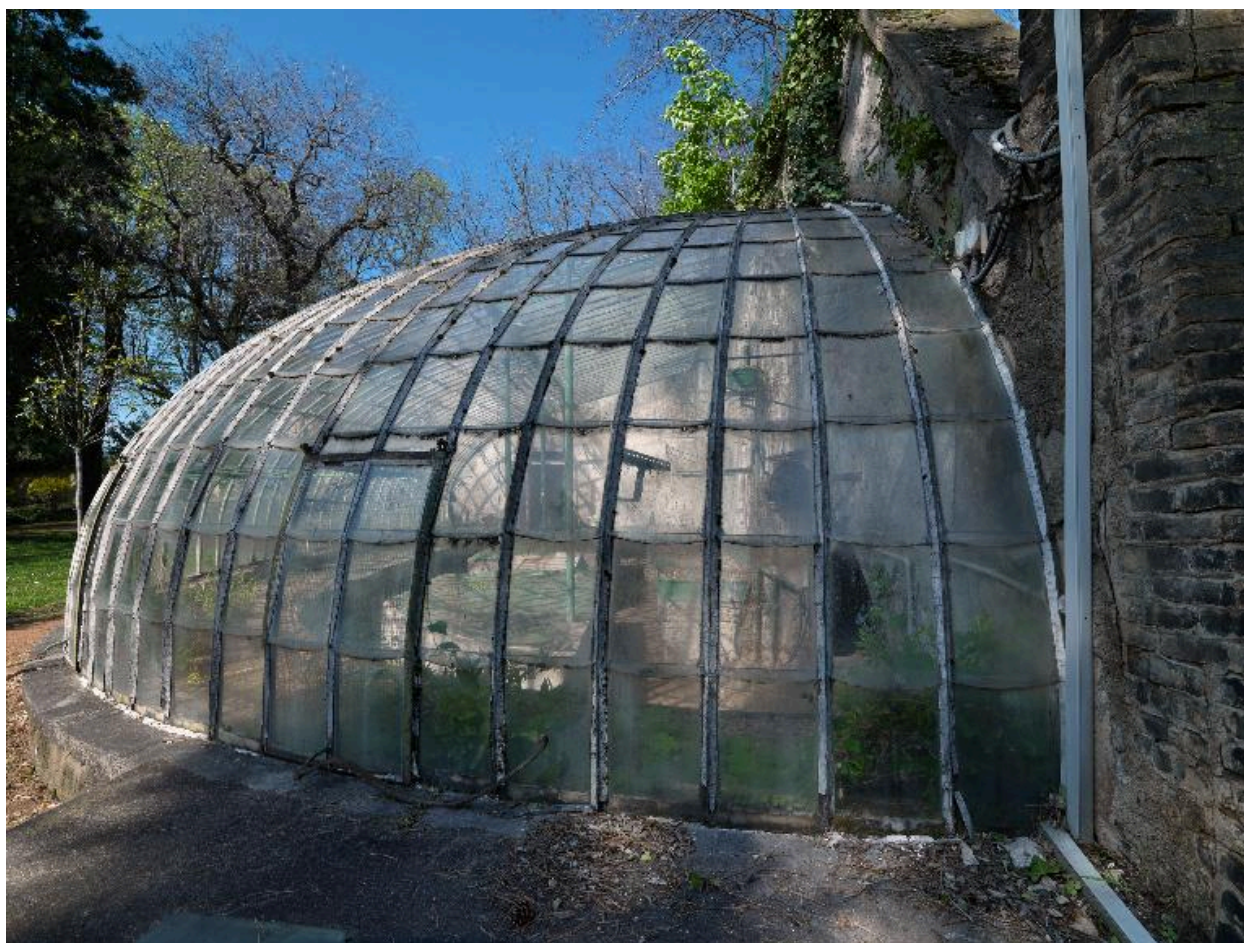
Serre, détail de la paroi vitrée
