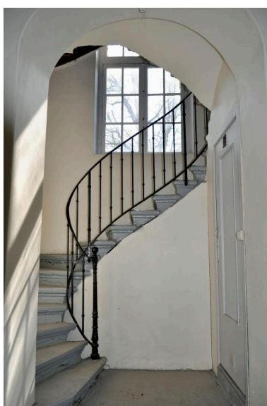
Château d'eau, vue intérieure : l'escalier
