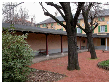
Cour nord-ouest, vue des portiques avant remaniement Phot. Véronique Belle IVR82_20046901016NUCA
