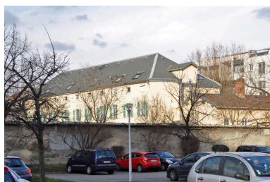
Aile sud, vue partielle de l'élévation postérieure Phot. Magali Delavenne IVR84_20186901047NUCA
