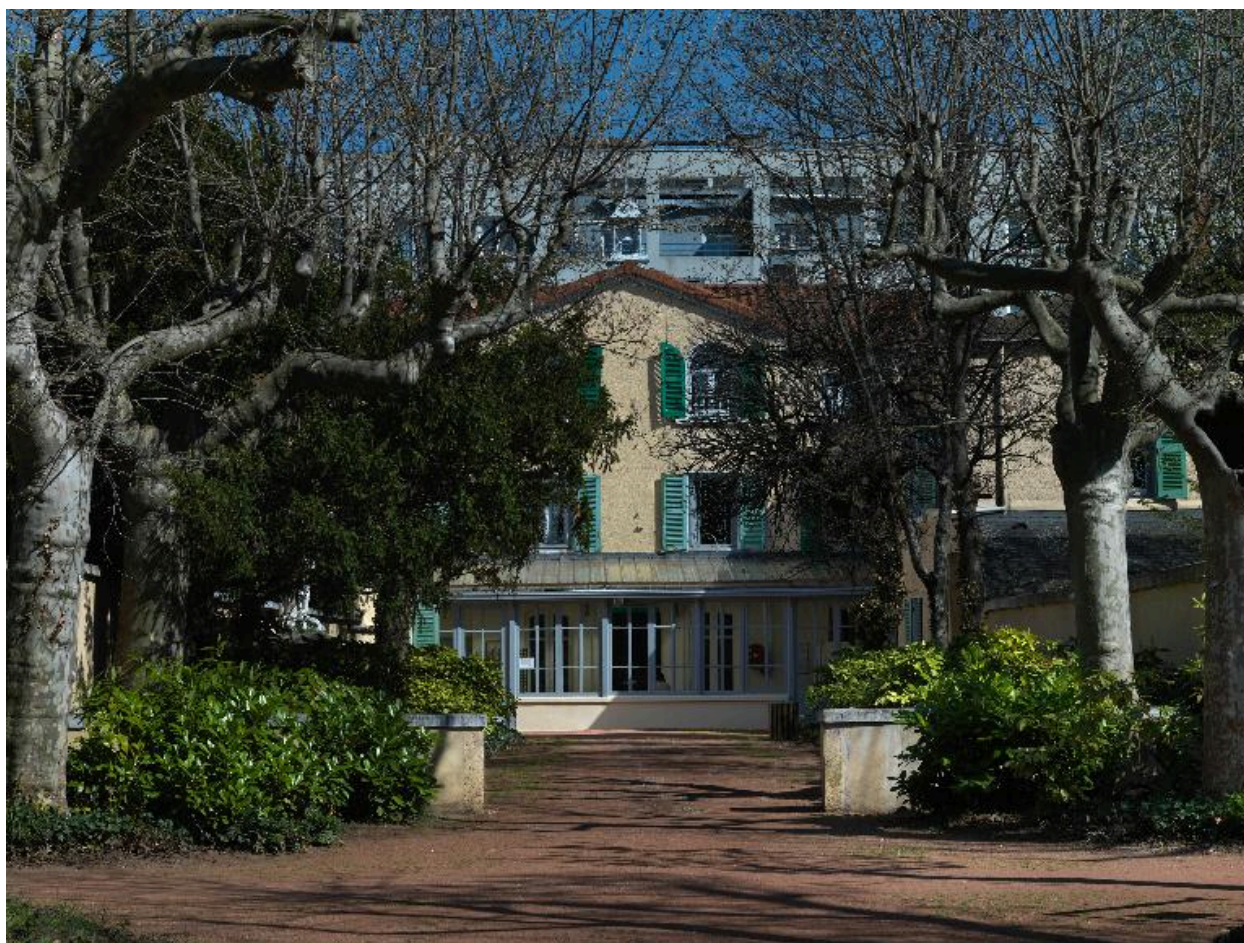
Bâtiment central, élévation postérieure
