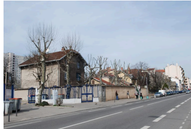
Vue d'ensemble avec maisons voisines Phot. Catherine Guégan IVR82_20096900628NUCA
