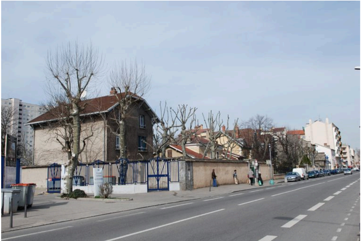
Vue d'ensemble avec maisons voisines
