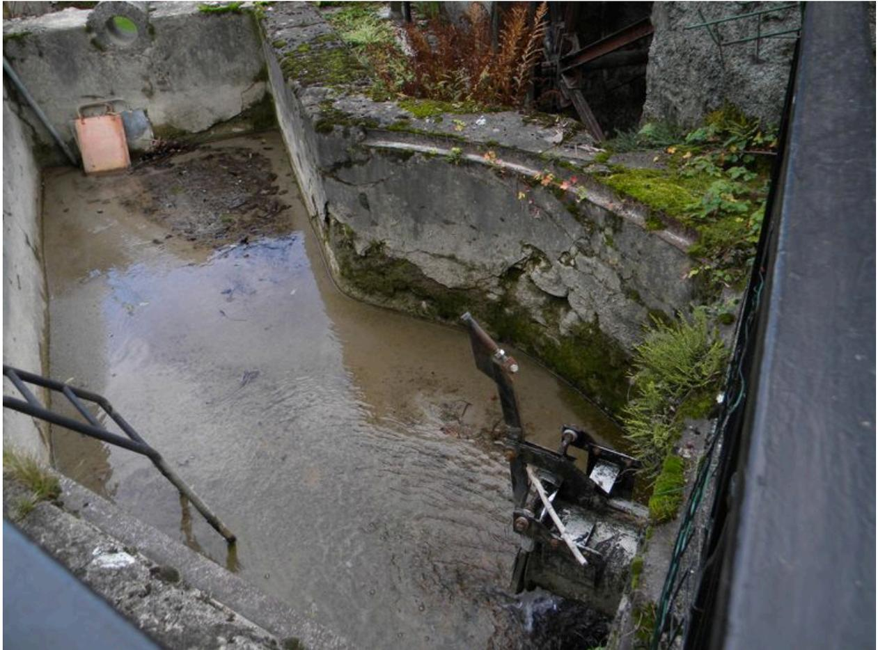
Vue de la cuve de charge du belier hydraulique.
