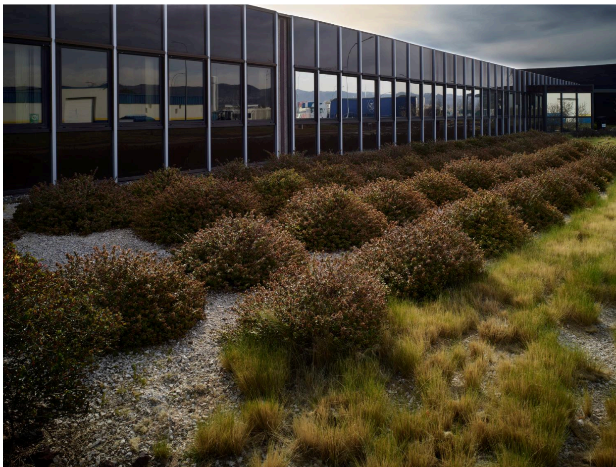
Locaux administratifs du site des Gravanches.
