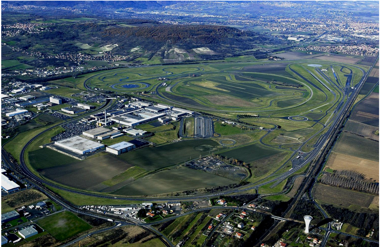
Vue aérienne du site de Ladoux en novembre 2002.
