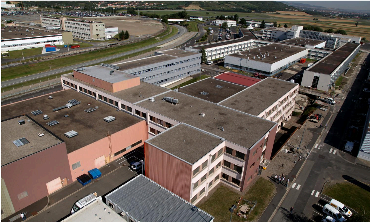
Vue partielle du site de Ladoux en juillet 2012.
