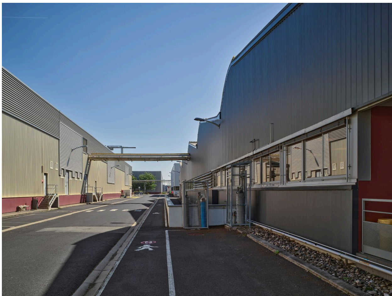
Deux bâtiments du site de la Combaude.
