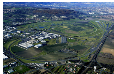
Vue aérienne du site de Ladoux en novembre 2002. Phot. auteur inconnu IVR84_20256301054NUCA
