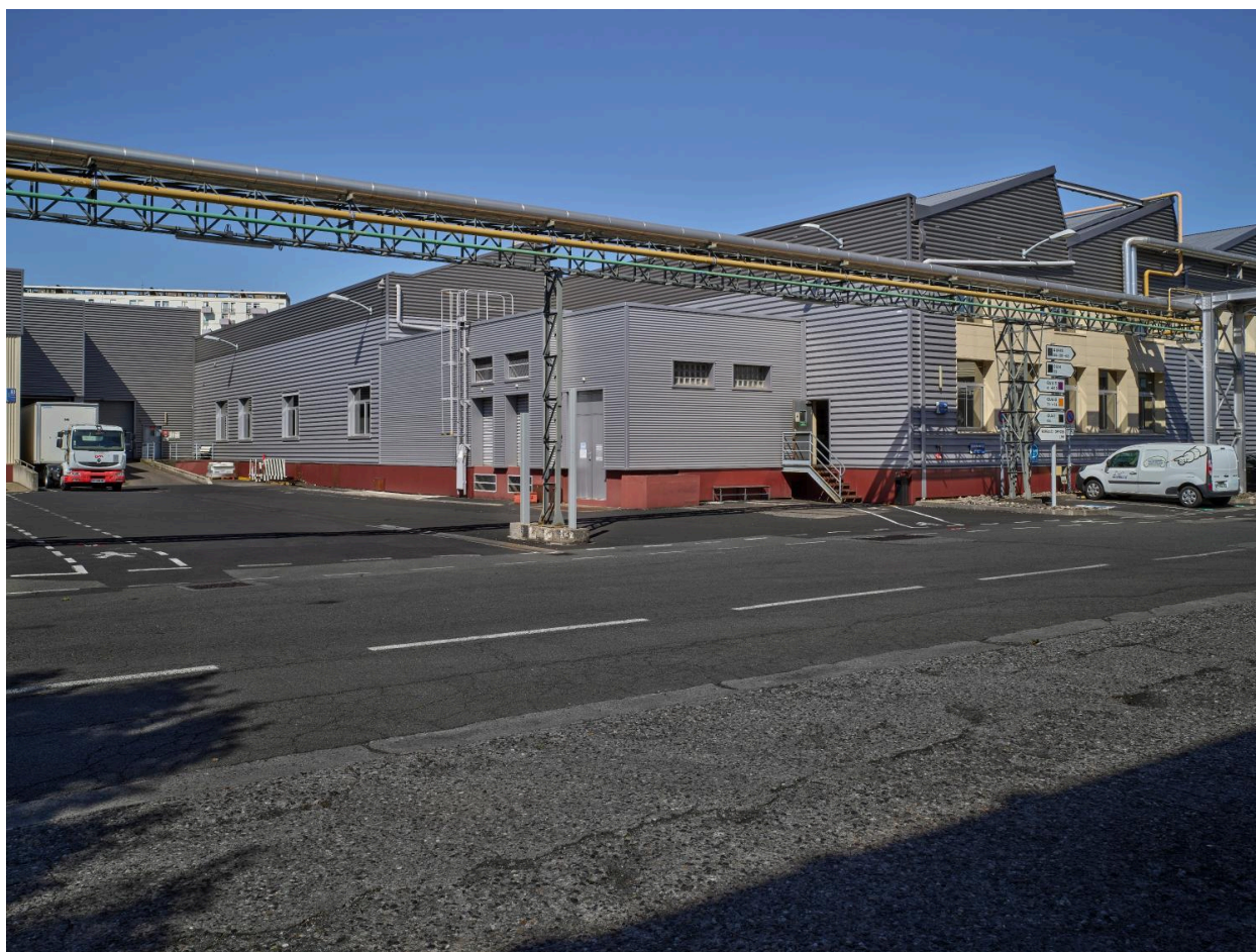
Vue partielle du site de la Combaude.
