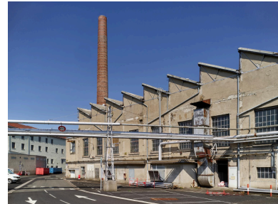
Cheminée et bâtiments de la chaufferie du site de Cataroux. Phot. Christian Parisey IVR84_20226301494NUC4A
