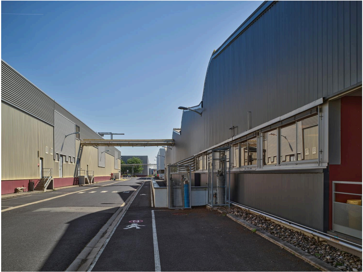
Deux bâtiments du site de la Combaude.
