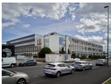
Le centre-livreur du Brézet, sur la rue Nicolas-Joseph- Cugnot, depuis le nord-ouest. Phot. Christian Parisey IVR84_20226304575NUC4A
