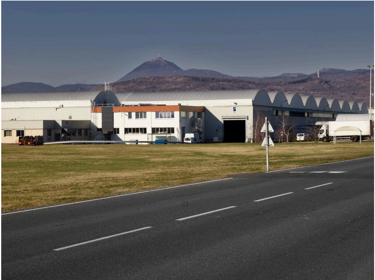
Vue partielle du site logistique de Chantemerle.
