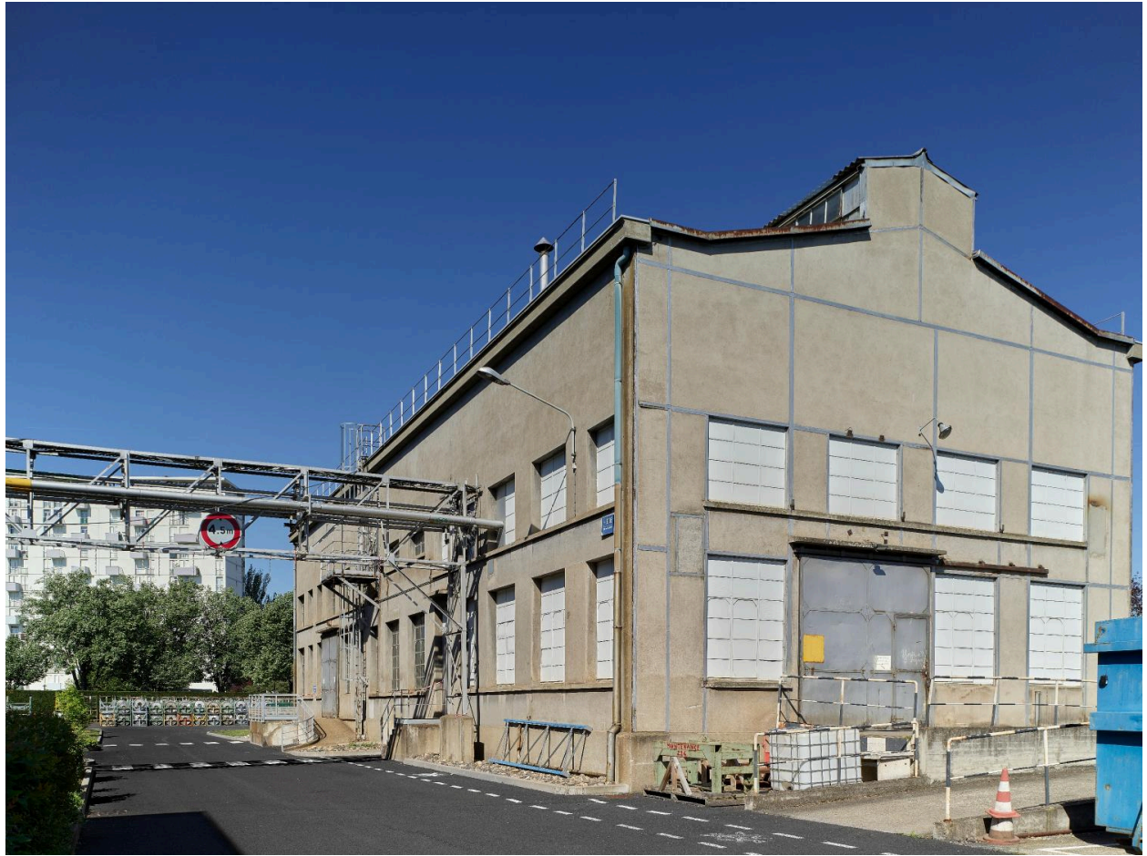
Ancien bâtiment de la chaufferie sur le site de la Combaude.
