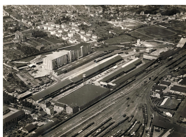
Vue aérienne du site Estaing au tournant des années 1920-1930. Repro. Service de collecte et de valorisation des collections historiques de la Manufacture française des pneumatiques Michelin., Autr. auteur inconnu IVR84_20246301742NUC
