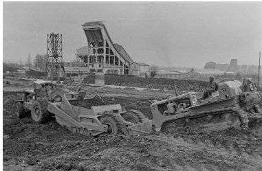
Chantier de construction sur le site de Cataroux, près des pistes d'essais déjà en place (fin des années 1950 ou début des années 1960 ?). Repro. Service de collecte et de valorisation des collections historiques de la Manufacture française des pneumatiques Michelin., Autr. auteur inconnu IVR84_20236300199NUC
