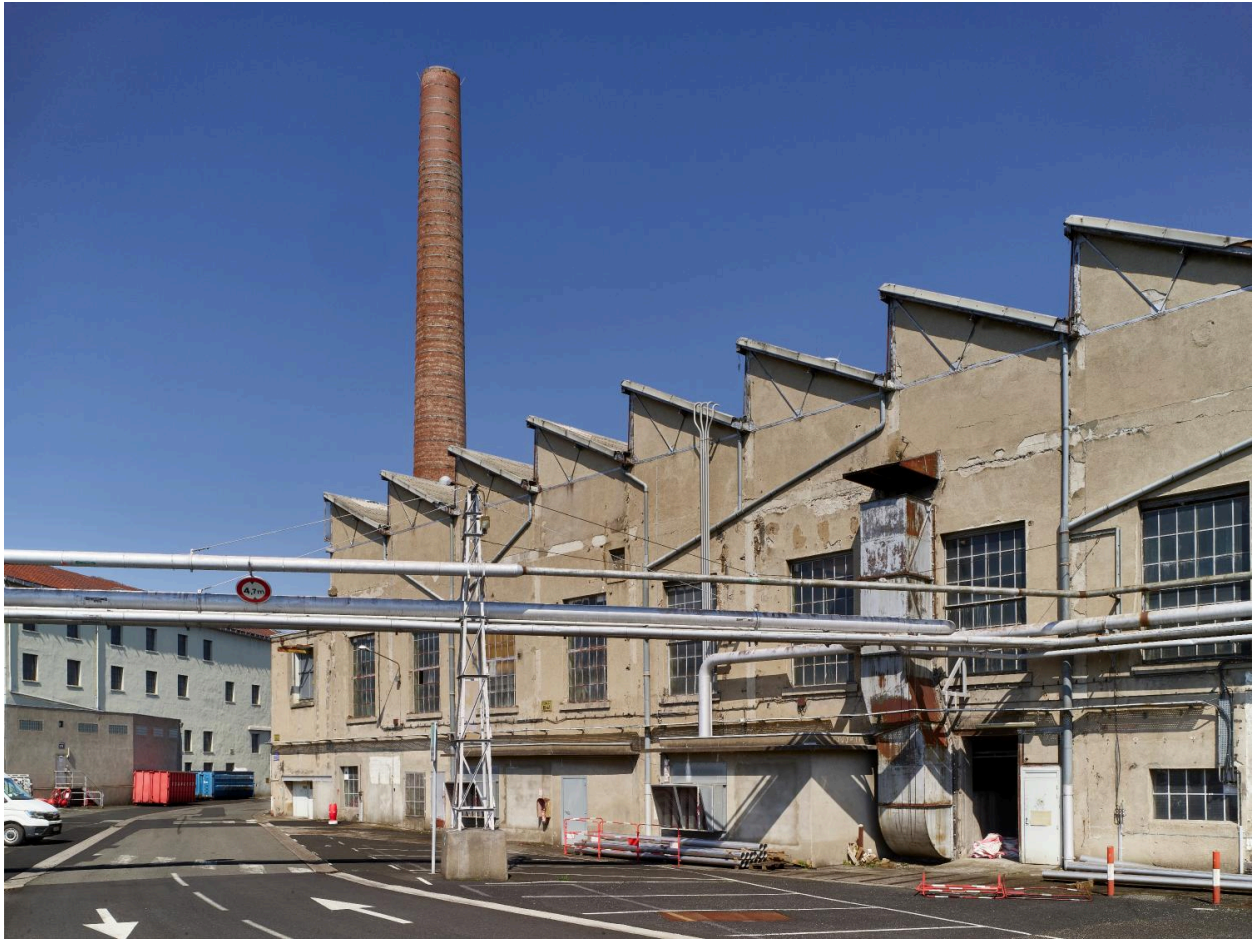
Cheminée et bâtiments de la chaufferie du site de Cataroux.
