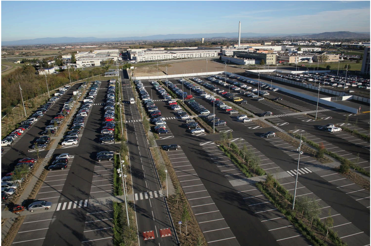
Vue partielle du site de Ladoux en octobre 2012.
