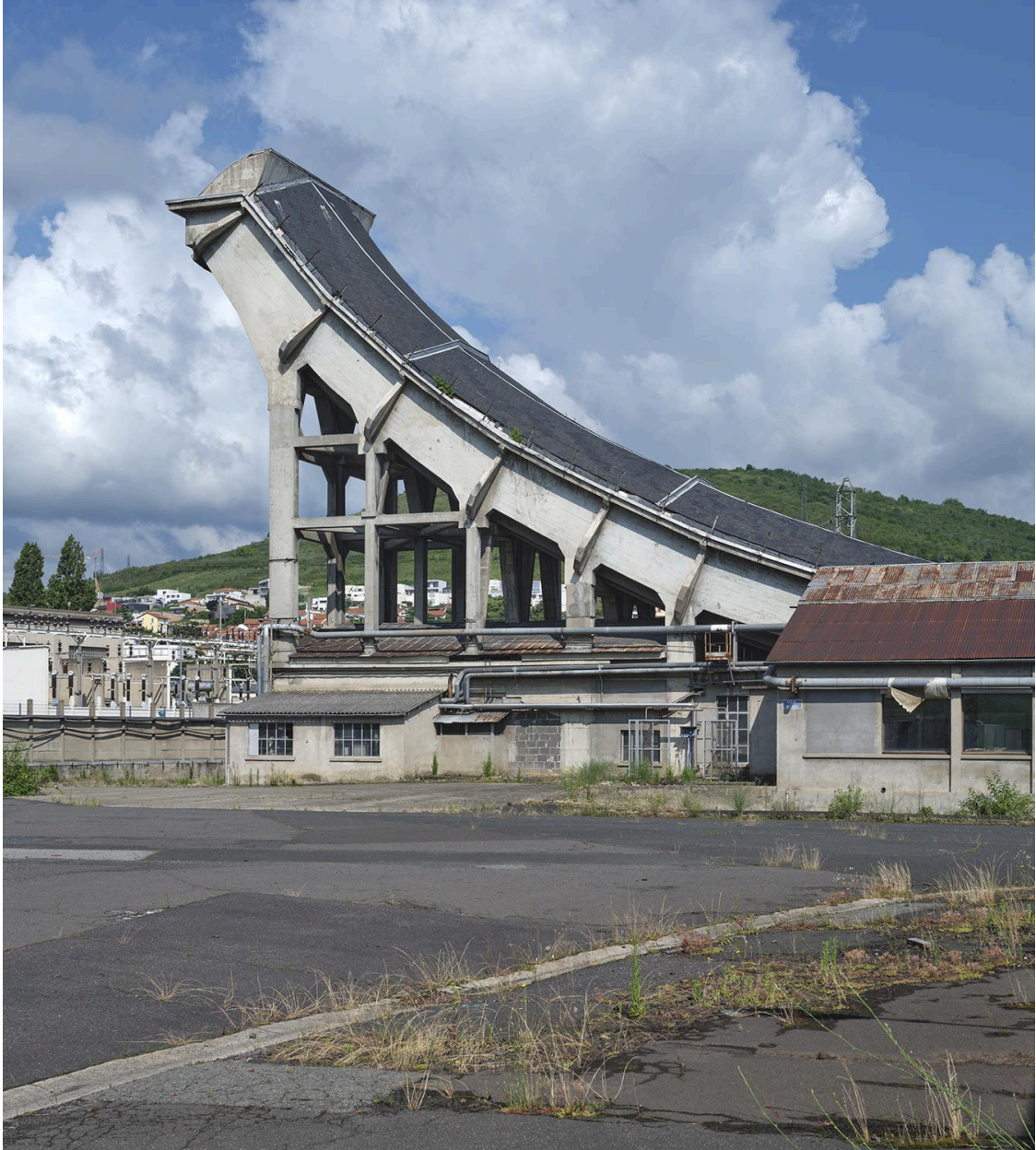
Un des bâtiments des pistes d'essais, sur le site de Cataroux.
