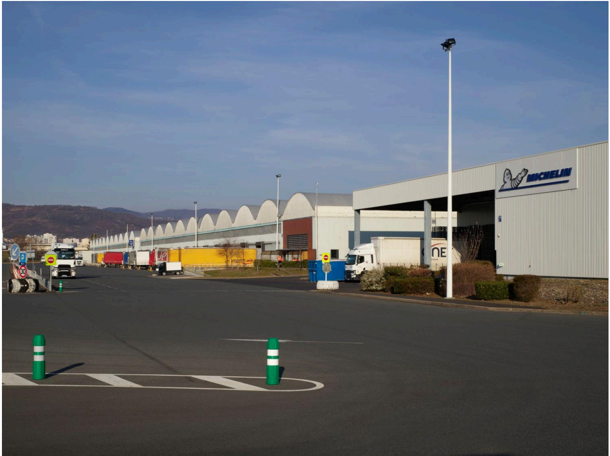
Vue générale du site de Chantemerle depuis le sud-est.
