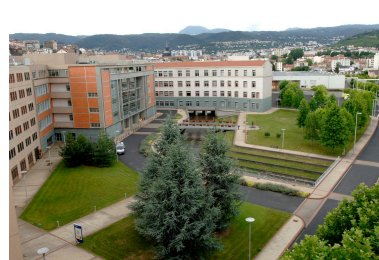
Vue aérienne de la partie sud du site des Carmes en 2009. Repro. Service de collecte et de valorisation des collections historiques de la Manufacture française des pneumatiques Michelin., Autr. auteur inconnu IVR84_20246301729NUCA
