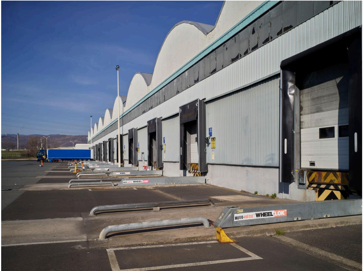
Un entrepôt et des quais de chargement sur le site de Chantemerle.
