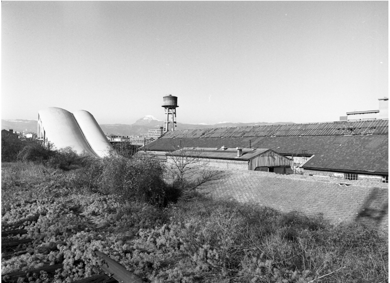
Bâtiments industriels et pistes d'essais du site Estaing détruit en 2005.
