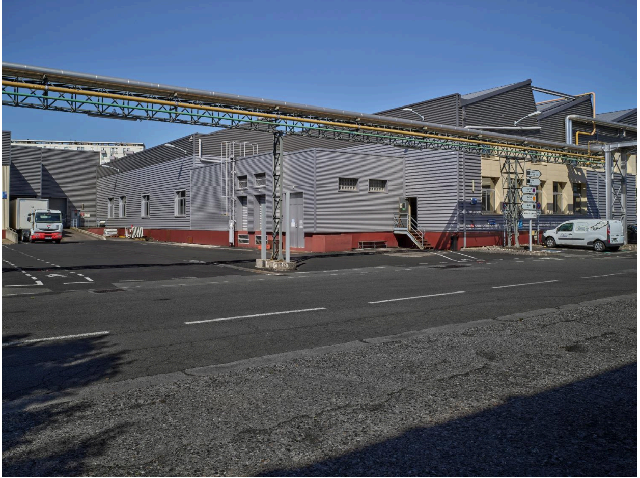
Vue partielle du site de la Combaude.
