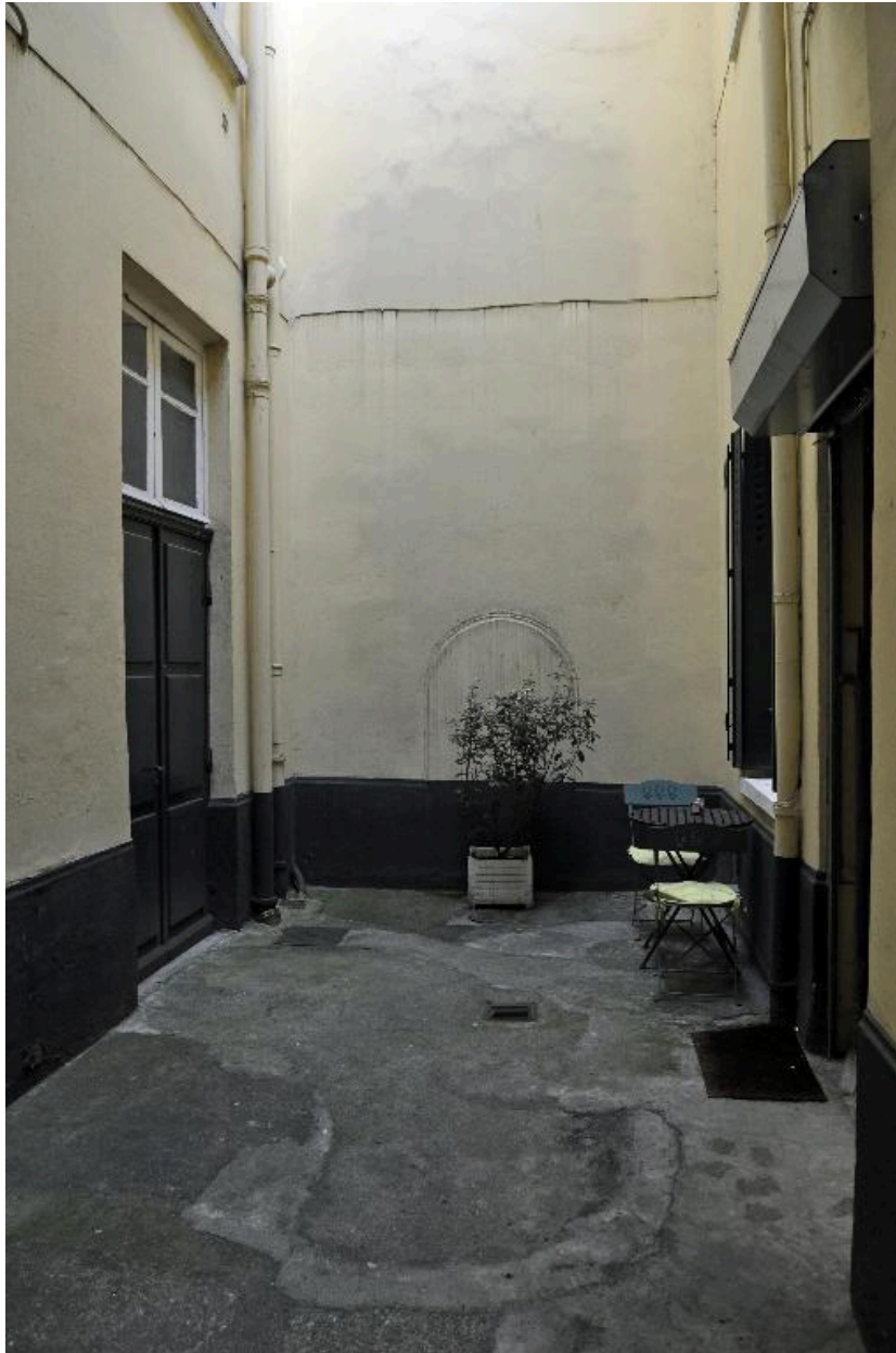
Cour, traces d'une ancienne fontaine ?
