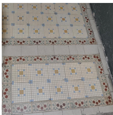
Immeuble sur rue, détail du pavement de l'allée Phot. Catherine Guégan IVR84_20176900999NUCA
