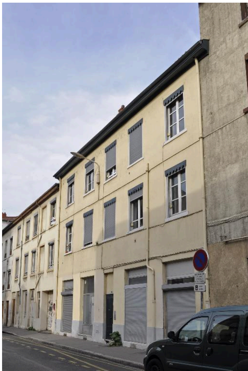
Immeuble sur rue, vue de l'élévation antérieure
