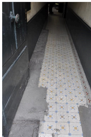
Immeuble sur rue, vue du pavement de l'allée Phot. Catherine Guégan IVR84_20176900994NUCA
