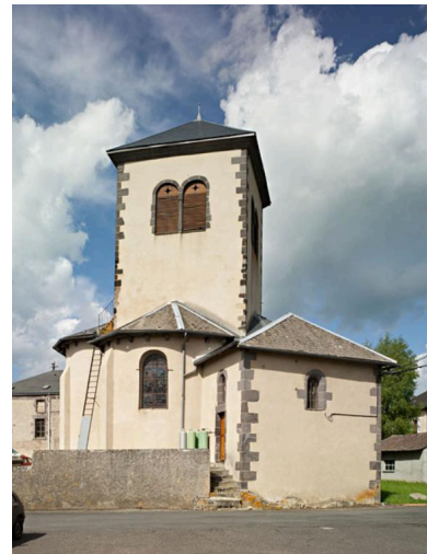
Vue du chevet. Phot. Jean-Michel Périn IVR83_20146300314NUC4A
