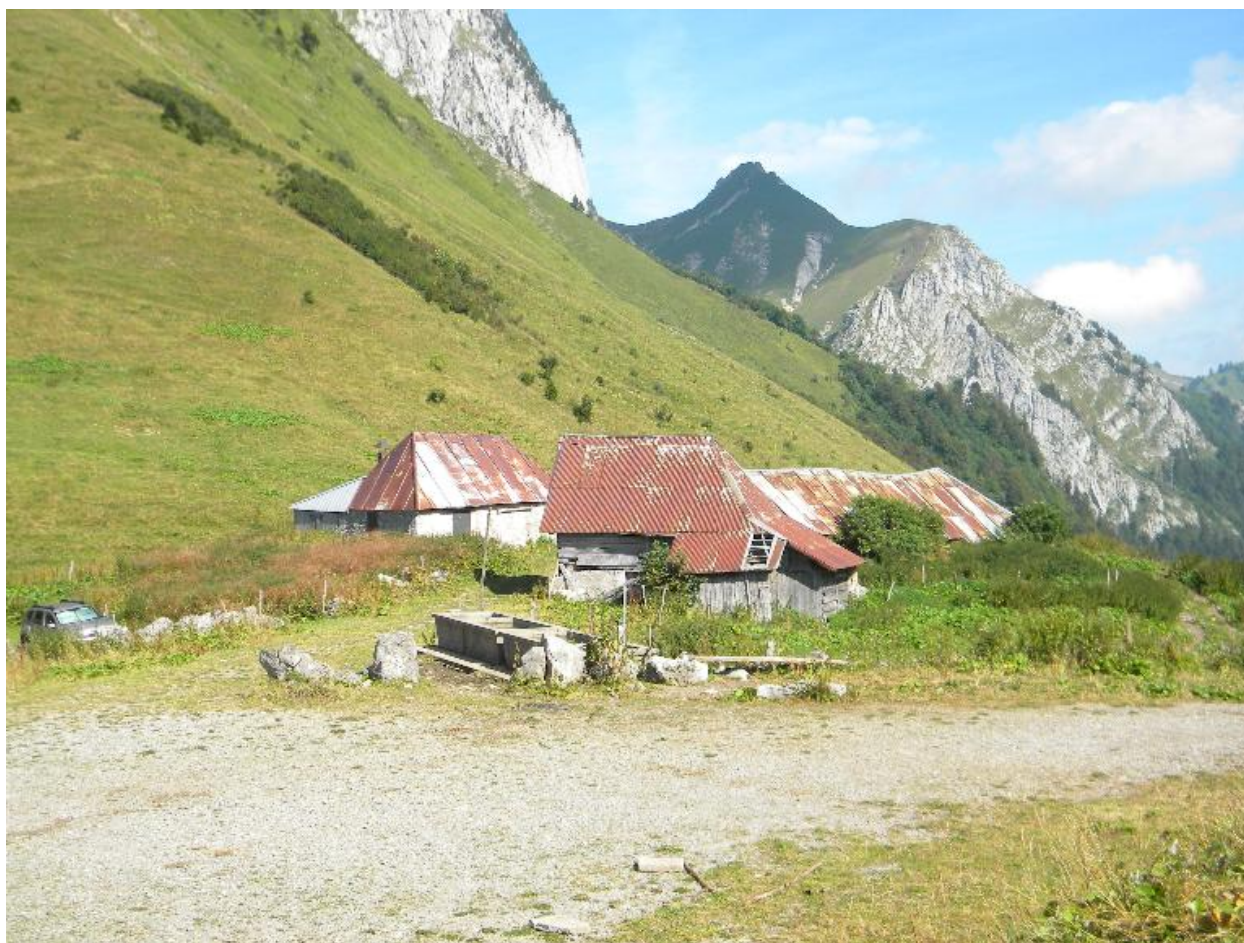
Vue d'ensemble des chalets d'alpage.
