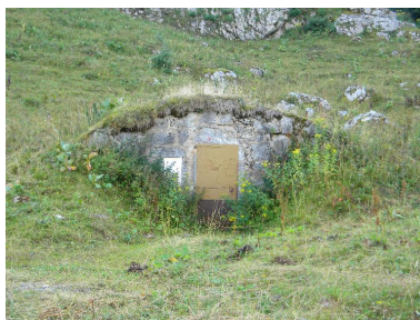
Vue d'une ancienne cave semi-enterrée. Phot. Jérôme Daviet IVR84_20167304459NUCA
