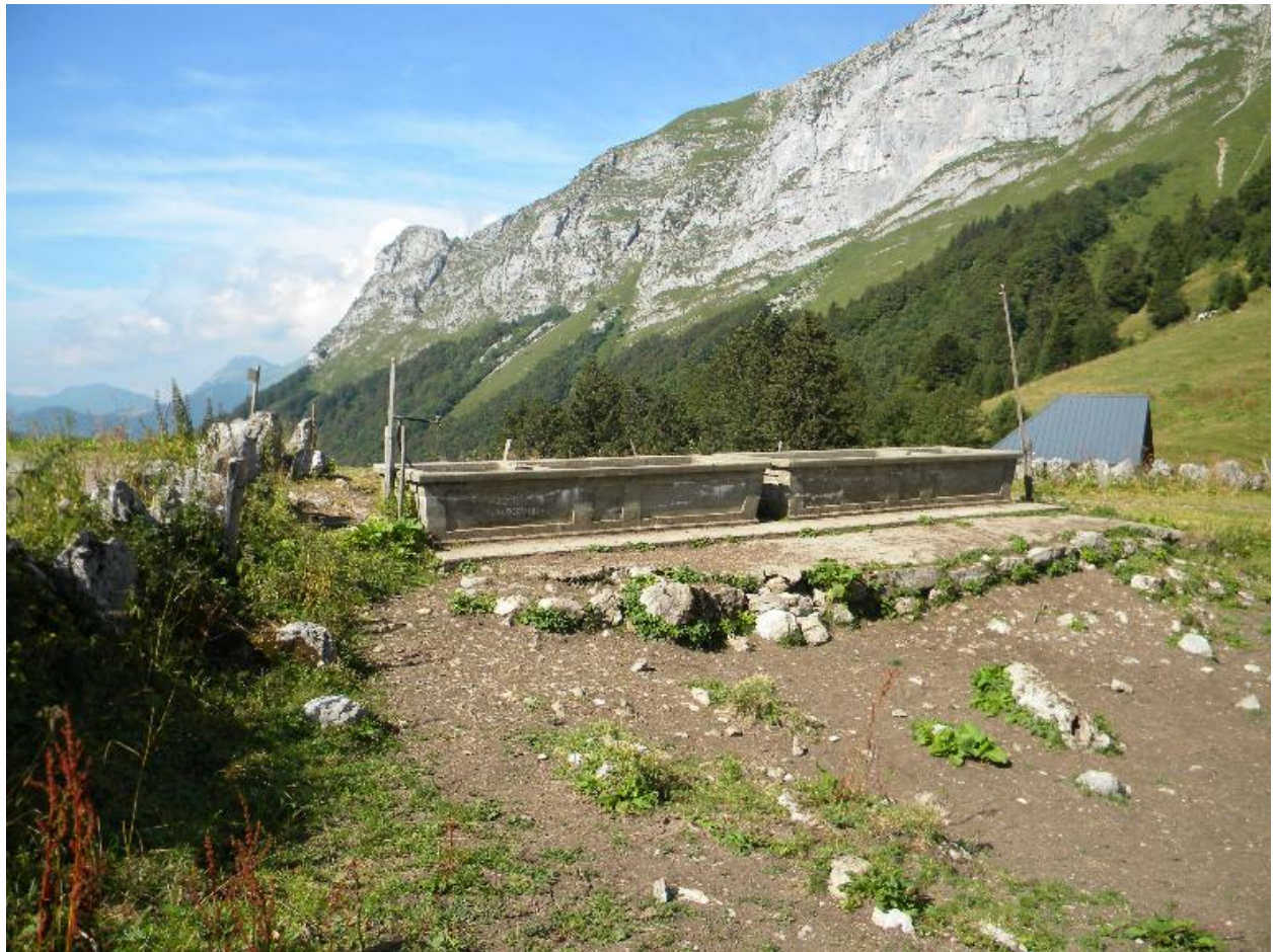
Vue des bassins en béton.
