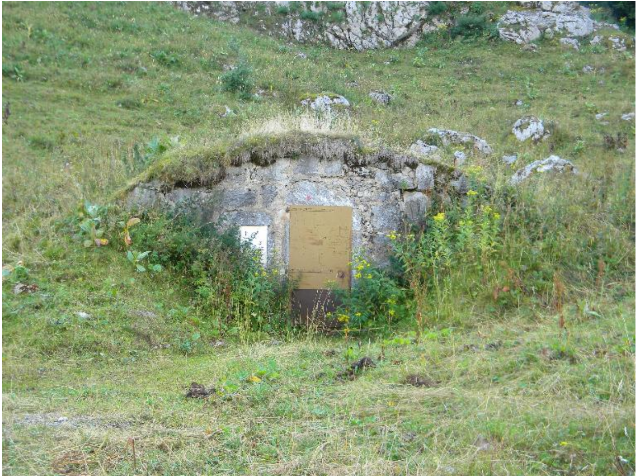
Vue d'une ancienne cave semi-enterrée.
