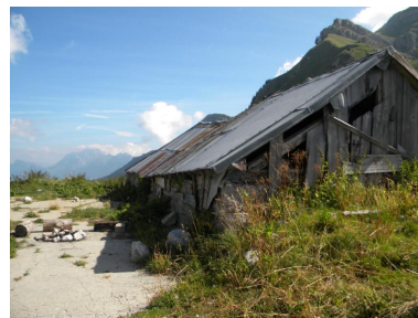
Vue de l'étable depuis le sud. Phot. Jérôme Daviet IVR84_20167306713NUCA
