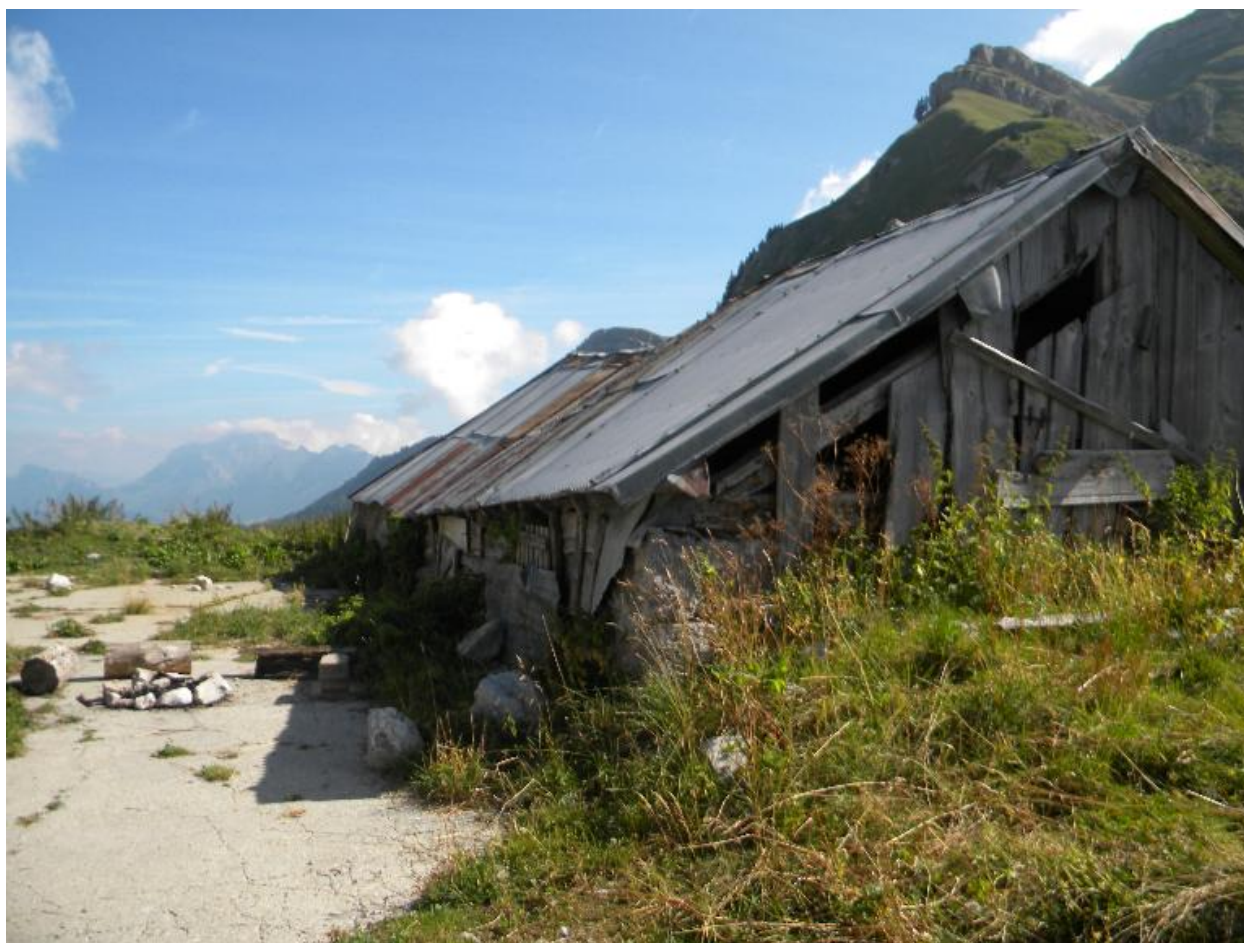
Vue de l'étable depuis le sud.
