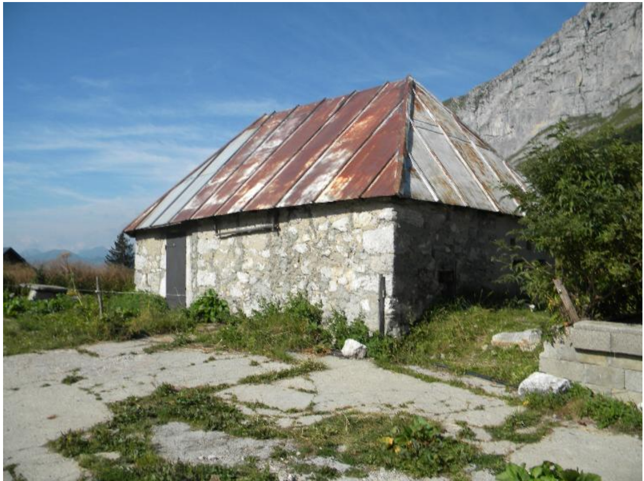
Vue de trois-quarts nord-est du bâtiment d'habitation.
