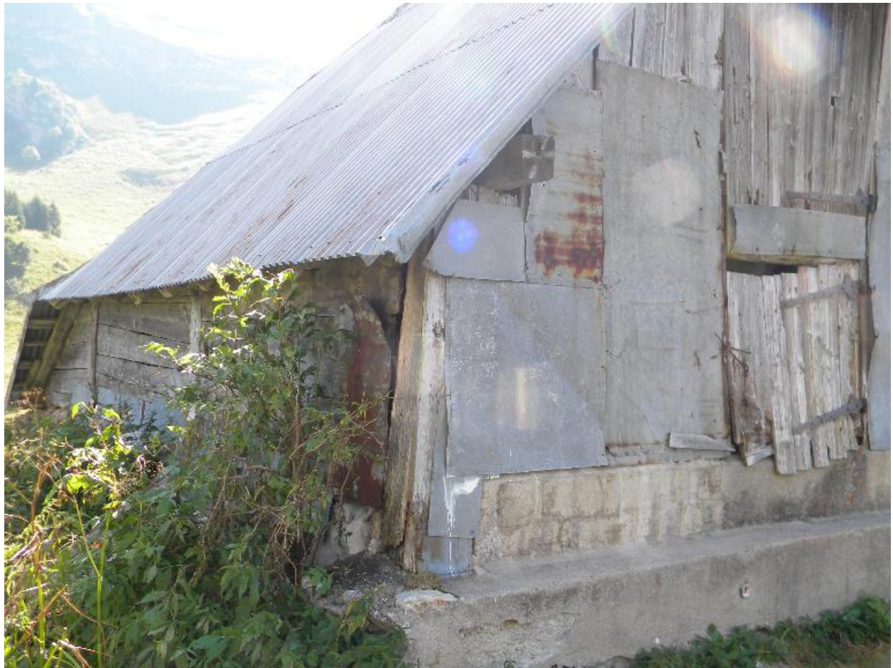
Vue de trois-quarts nord-ouest d'une étable secondaire.
