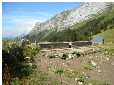
Vue des bassins en béton. Phot. Jérôme Daviet IVR84_20167304465NUCA
