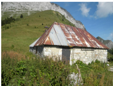
Vue de trois quarts sud- est du bâtiment d'habitation. Phot. Jérôme Daviet IVR84_20167306717NUCA
