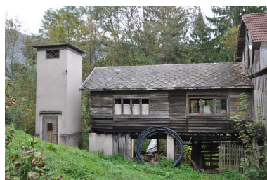
Vue de l'aile nord (atelier) avec le transformateur Phot. Yannick Milleret IVR82_20107300434NUCA
