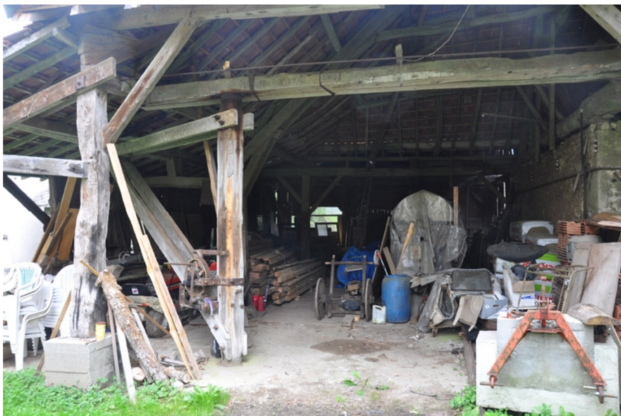
Vue de l'espace de sciage
