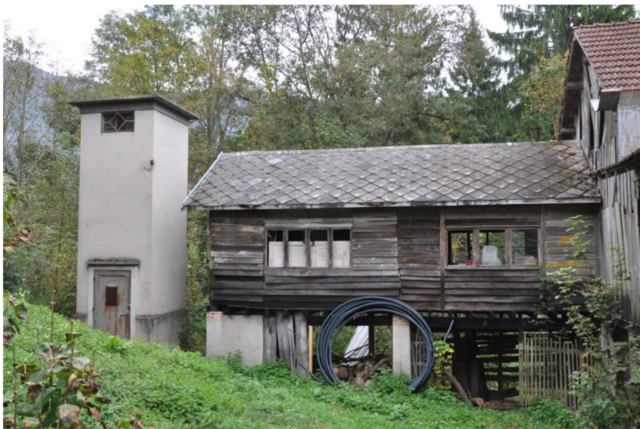
Vue de l'aile nord (atelier) avec le tranformateur
