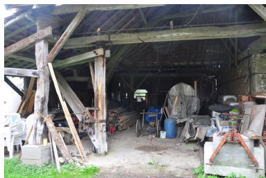
Vue de l'espace de sciage Phot. Yannick Milleret IVR82_20107300436NUCA
