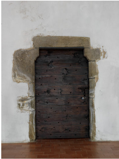
Encadrement de porte du 14e siècle.
