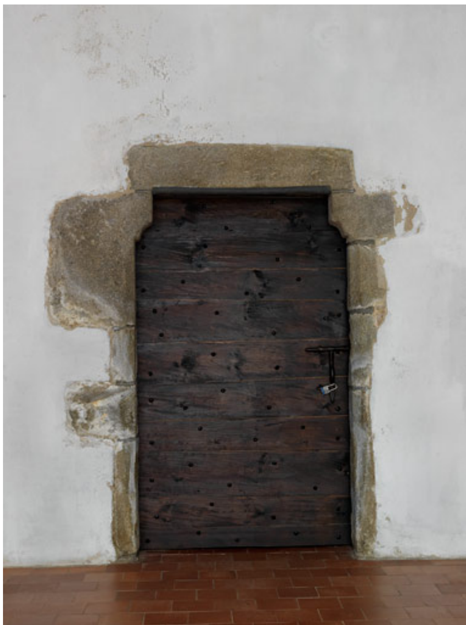
Encadrement de porte du 14 e siècle.
