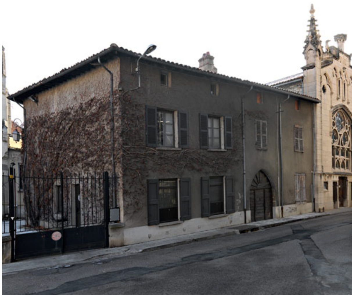
Maison vue de trois-quarts
