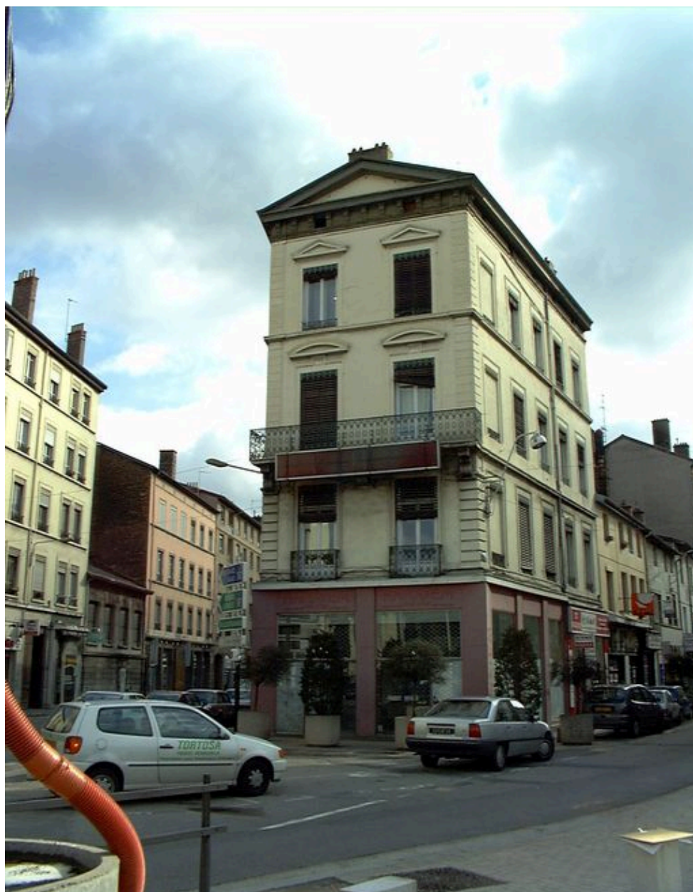
Vue générale depuis la place Valmy
