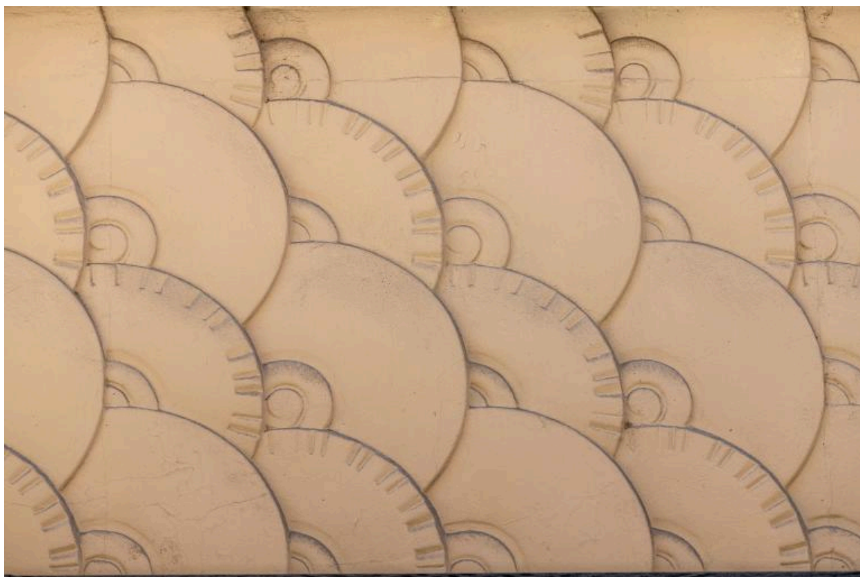
Entrée de l'immeuble : motif décoratif situé à droite
