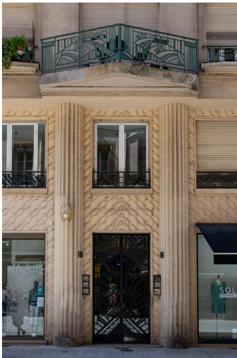
L'entrée de l'immeuble : vue générale
