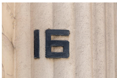
Entrée de l'immeuble : détail du numéro 16 en ferronnerie Phot. Michel Pérès IVR84_20206901149NUCA
