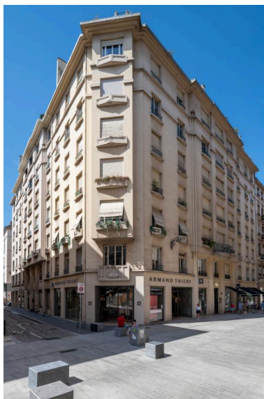
Vue générale Phot. Michel Pérès IVR84_20206901155NUCA
