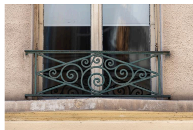
Détail d'un garde-corps Phot. Michel Pérès IVR84_20206901154NUCA
