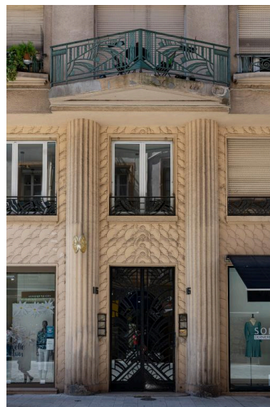
L'entrée de l'immeuble : vue générale Phot. Michel Pérès IVR84_20206901148NUCA
