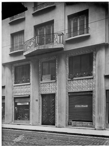
Partie de l'immeuble portant le décor de l'entreprise Vitet-Charbonnel, Florentin photographe à Lyon Repro. Thierry Leroy, Autr. Florentin IVR84_20206901049NUC
