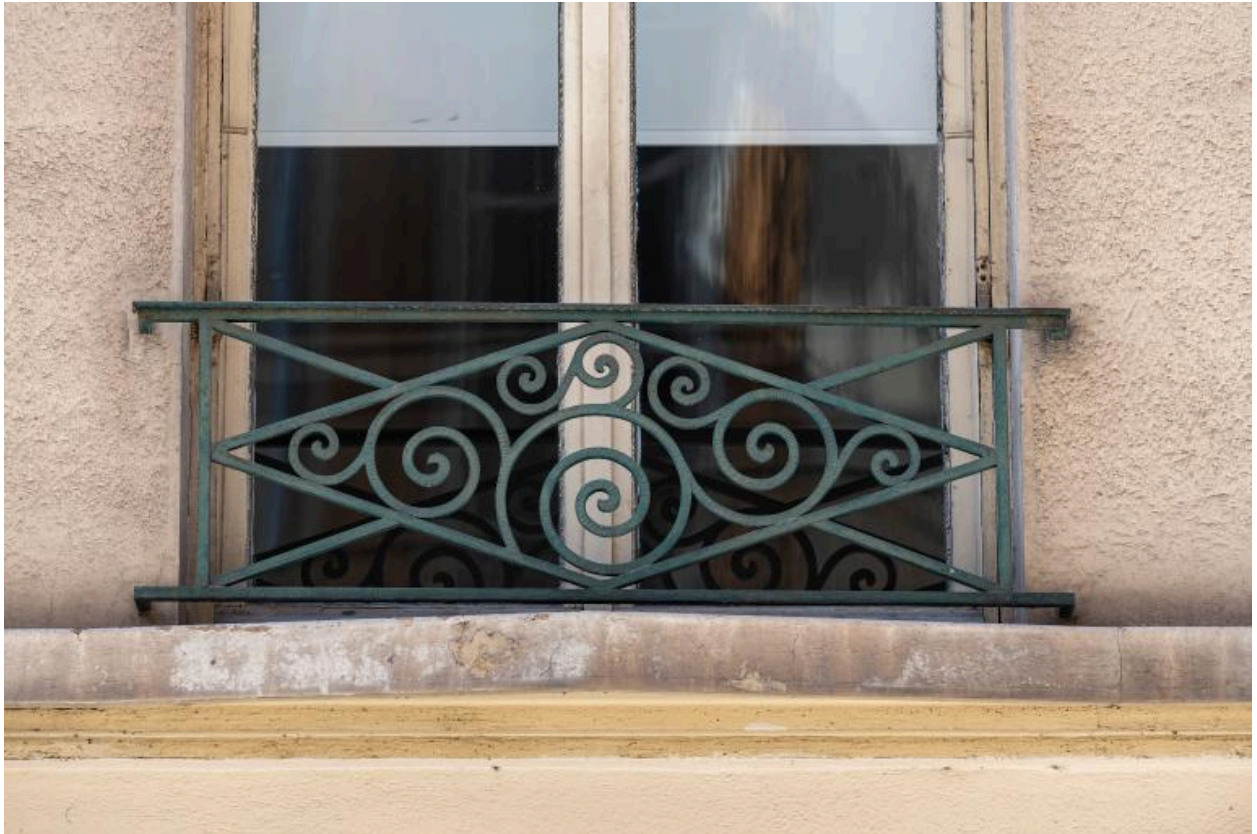
Détail d'un garde-corps
