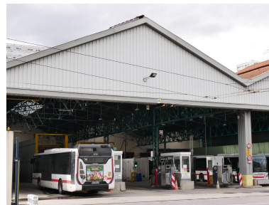
Détail dépôt TCL de Vaise Phot. Nadine Halitim-Dubois IVR84_20246900455NUCA
