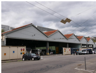
Vue d'ensemble du dépôt TCL Saint-Simon de Vaise Phot. Nadine Halitim-Dubois IVR84_20246900454NUCA
