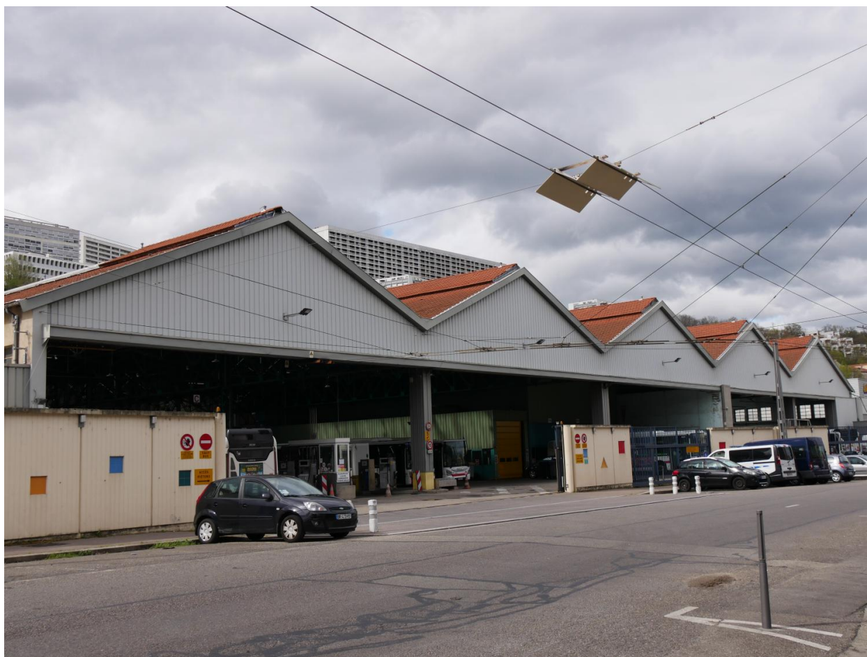
Vue d'ensemble du dépôt TCL Saint-Simon de Vaise
