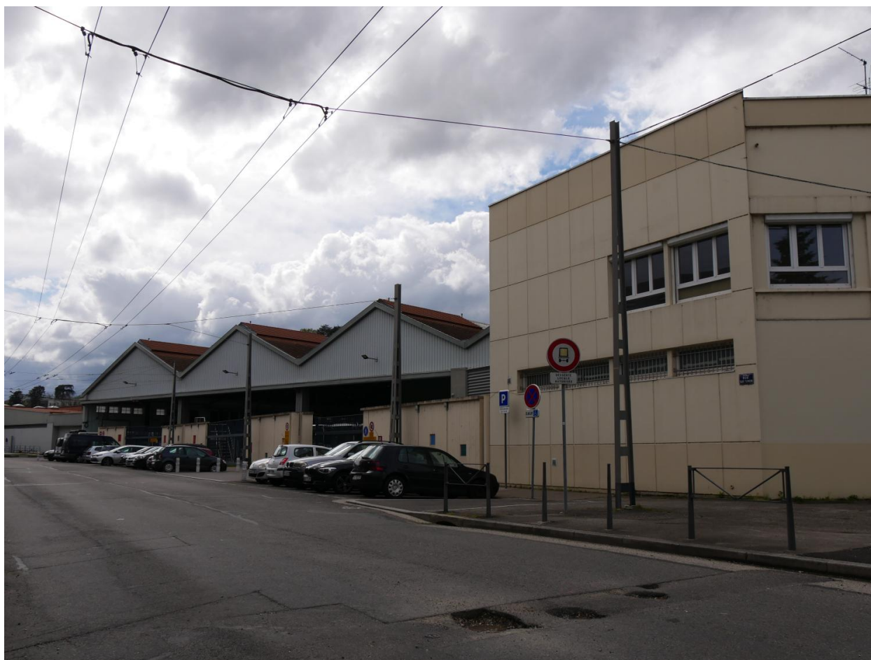
Vue nord du dépôt
