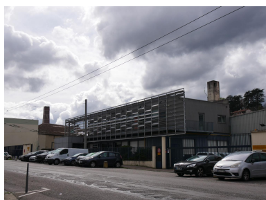
Détail dépôt TCL de Vaise Phot. Nadine Halitim-Dubois IVR84_20246900459NUCA
