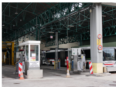
Détail charpente métallique Phot. Nadine Halitim-Dubois IVR84_20246900456NUCA
