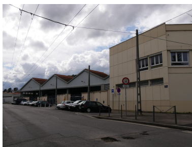
Vue nord du dépôt Phot. Nadine Halitim-Dubois IVR84_20246900457NUCA
