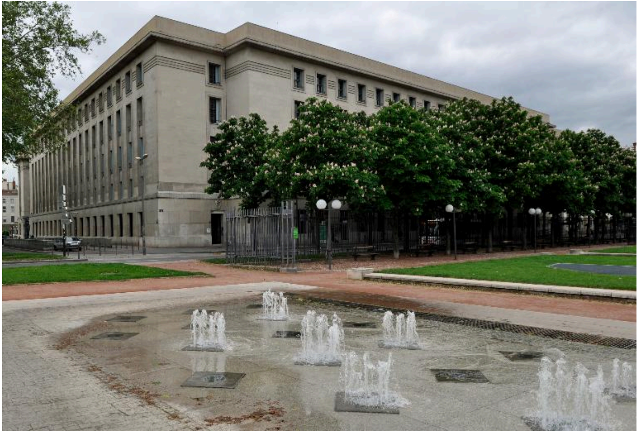
Vue d'ensemble, depuis le quai Gailleton (élévations nord et est)
