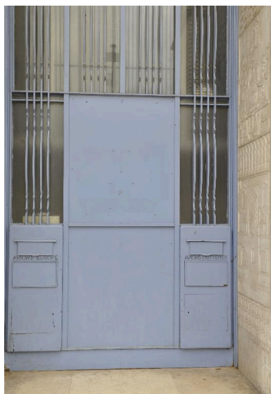
Elévation nord : décor d'une porte monumentale au 4-6 place Antonin-Poncet (ferronneries, bas-reliefs, boîtes postales) Phot. Magali Delavenne IVR84_20166900865NUCA
