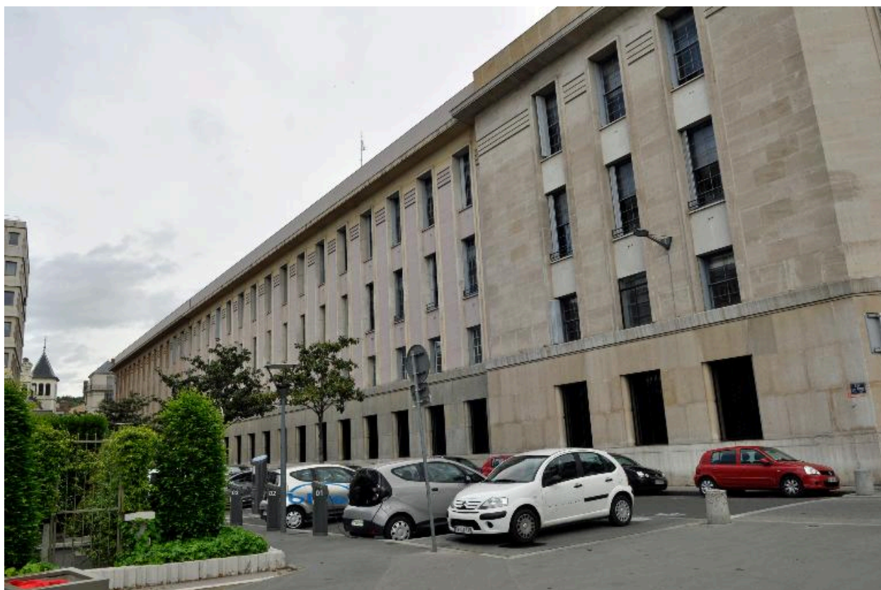
Vue générale de l'élévation sud
