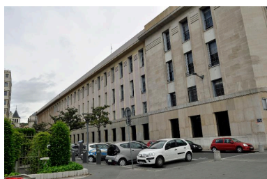
Vue générale de l'élévation sud Phot. Magali Delavenne IVR84_20166900869NUCA
