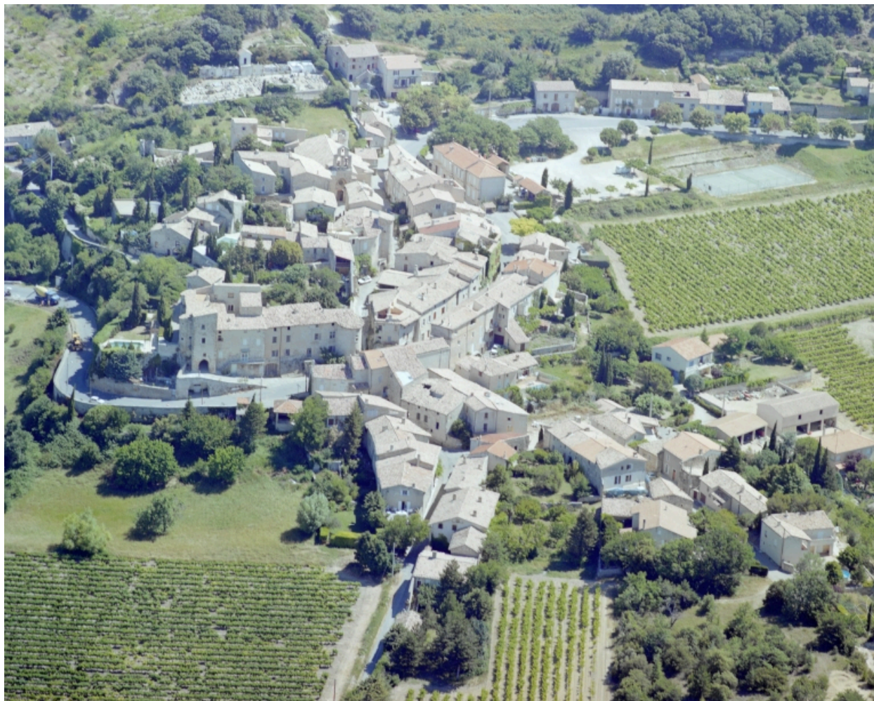
Vue aérienne depuis l'ouest.
