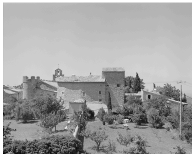
Vue depuis le nord-est : église et maison adossée à l'enceinte. Phot. Alain Franchella IVR82_19982600458X
