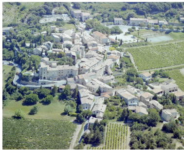
Vue aérienne depuis l'ouest. Phot. Alain Franchella IVR82_20002601331XE
