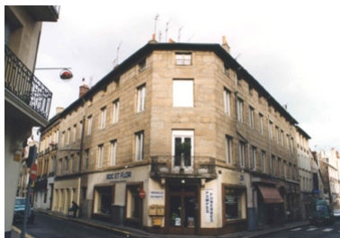
Vue d'ensemble. Etat en 1996 Phot. Cendrine Sanquer IVR82_19974202002ZE
