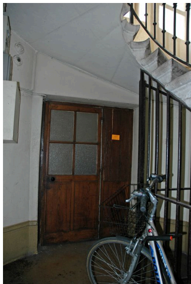
Entrée de la loge de concierge sous l'escalier Phot. Maryannick Chalabi IVR82_20066903141NUCA
