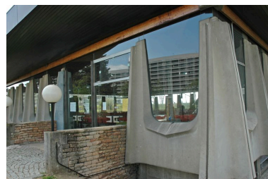
Façade postérieure Phot. Didier Gourbin IVR82_20066902166NUCA
