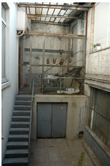
Vue de la cour actuellement couverte Phot. Maryannick Chalabi IVR82_20066903139NUCA
