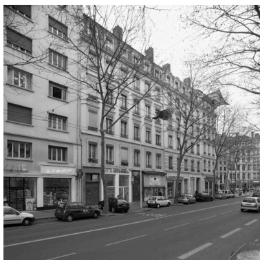
Elévation principale depuis le nord-est Phot. Eric Dessert IVR82_20056900604NUC
