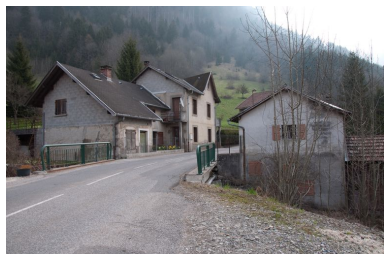
Vue générale Phot. Samir Mahfoudi, Autr. Samir Mahfoudi IVR82_20107400194NUCA
