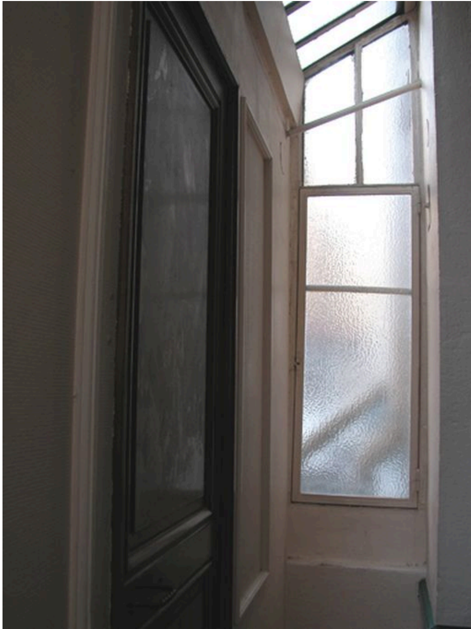
Baie éclairant le passage d'accès à la loge de concierge
