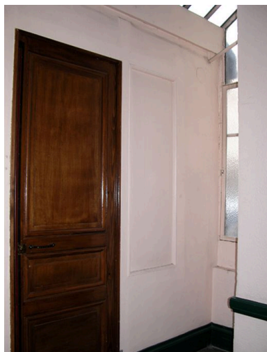
Porte d'entrée de la loge de concierge au niveau du 1er repos de l'escalier Phot. Maryannick Chalabi IVR82_20046904576NUCA
