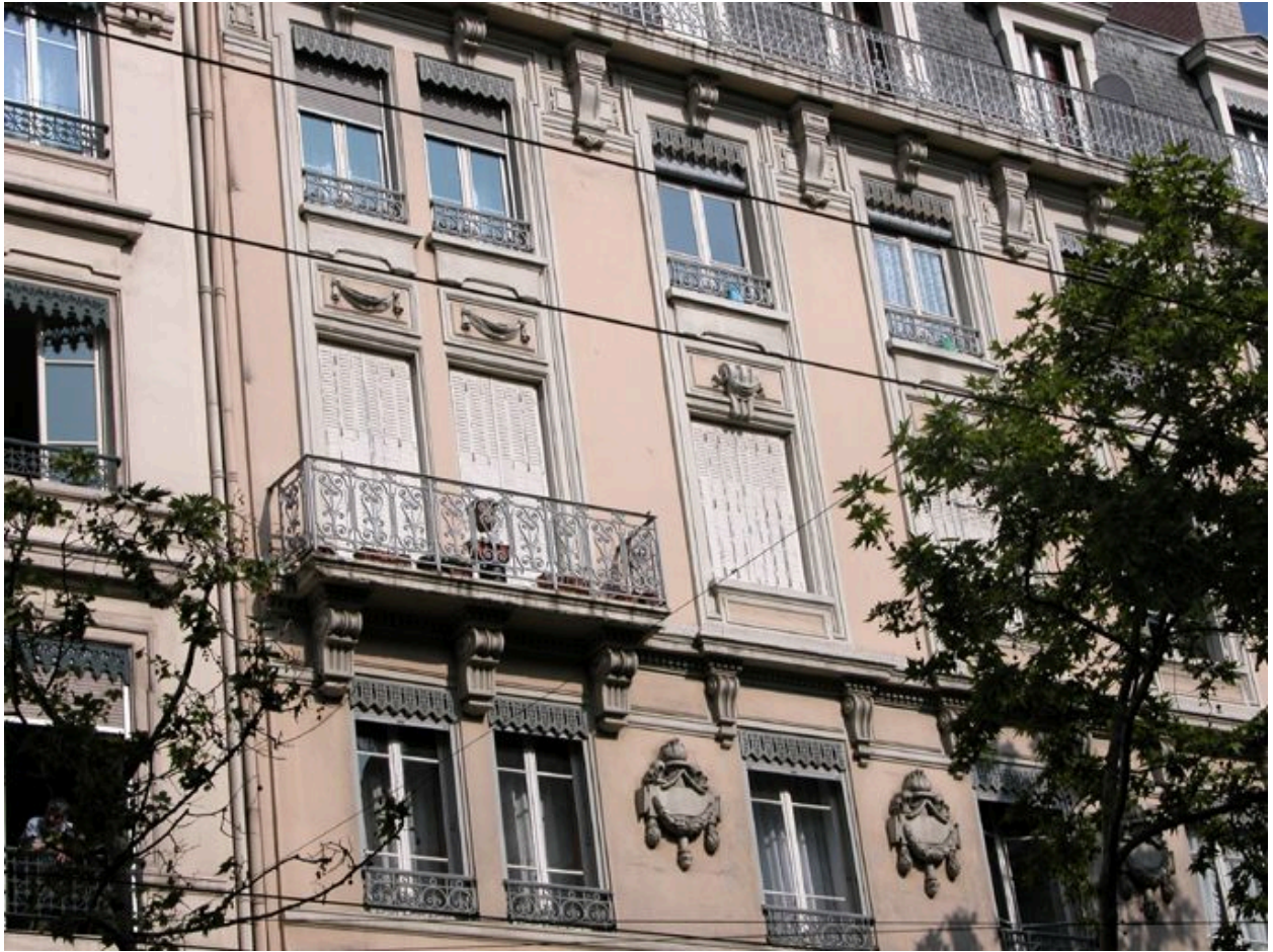
Détail d'un balcon en ferronnerie au 2e étage, travées latérales
