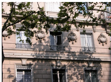
Détail des fenêtres du 1er étage Phot. Maryannick Chalabi IVR82_20046904568NUCA
