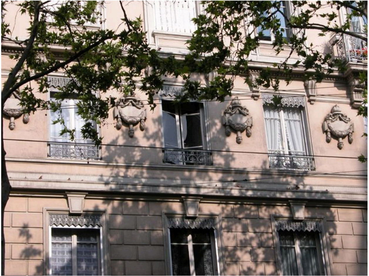
Détail des fenêtres du 1er étage
