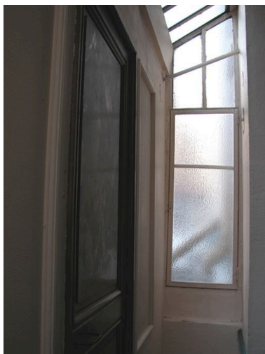
Baie éclairant le passage d'accès à la loge de concierge Phot. Maryannick Chalabi IVR82_20046904577NUCA
