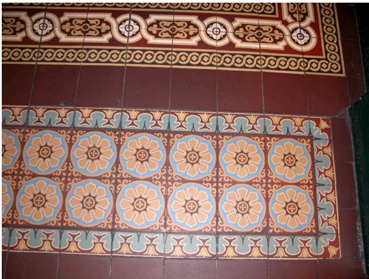
Détail du carrelage du vestibule
