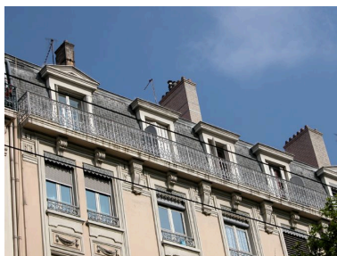
Vue du balcon filant de l'étage de comble Phot. Maryannick Chalabi IVR82_20046904569NUCA
