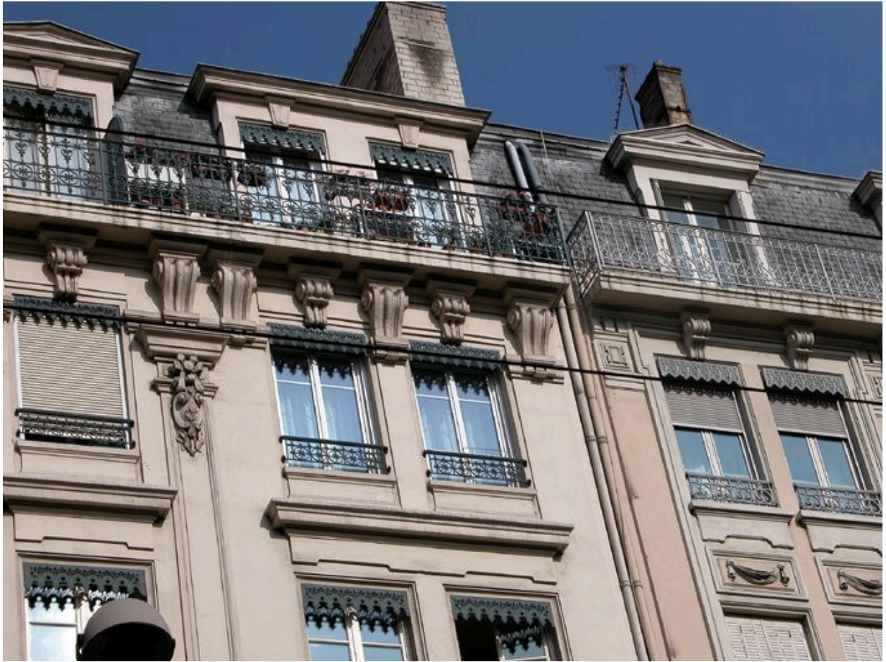
Détail du balcon filant du dernier niveau : prolongement entre les n° 10 et 12 avenue Jean-Jaurès
