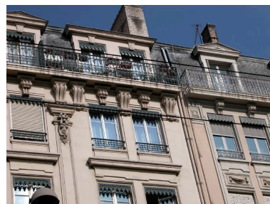
Détail du balcon filant du dernier niveau : prolongement entre les n° 10 et 12 avenue Jean-Jaurès Phot. Maryannick Chalabi IVR82_20046904570NUCA
