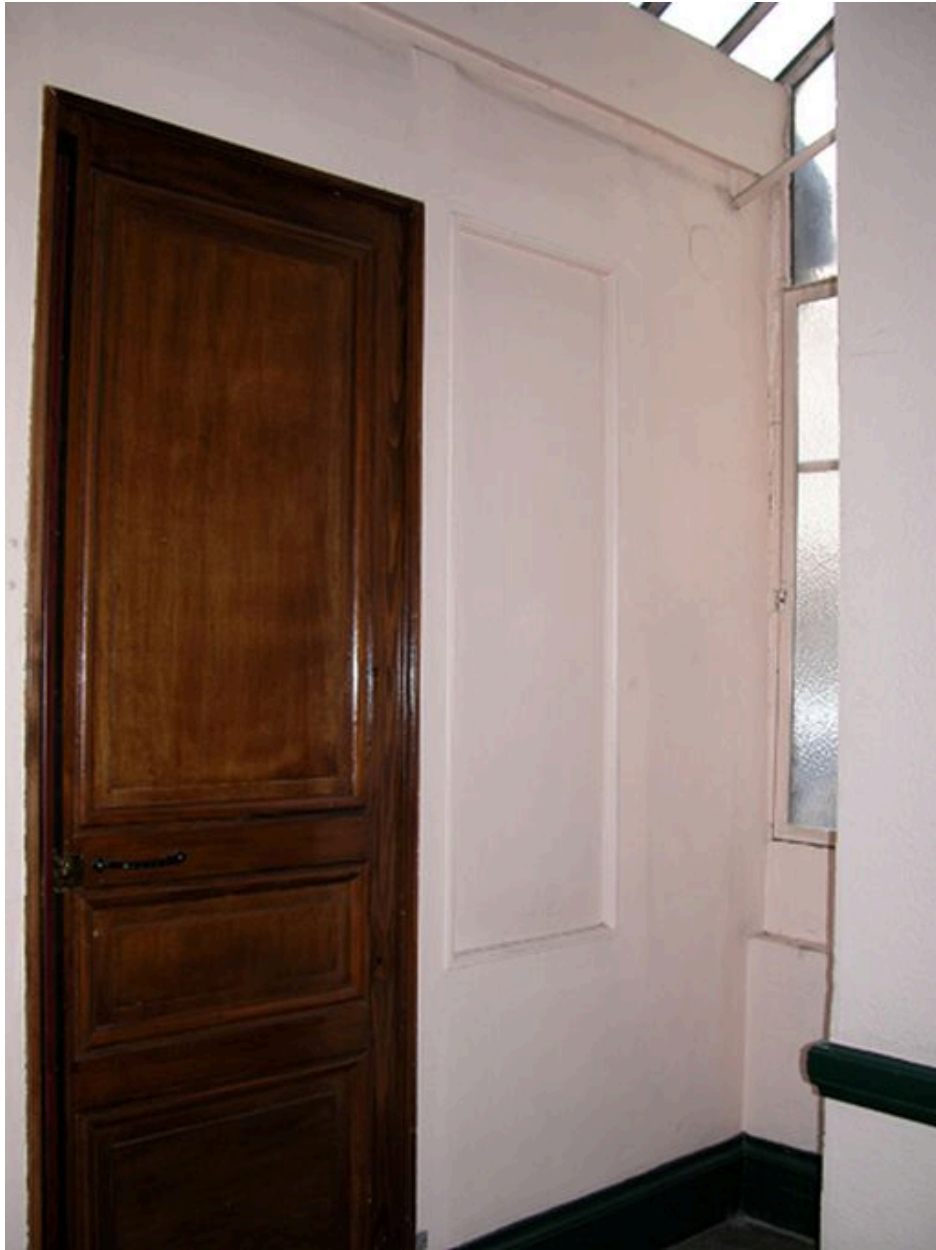
Porte d'entrée de la loge de concierge au niveau du 1er repos de l'escalier
