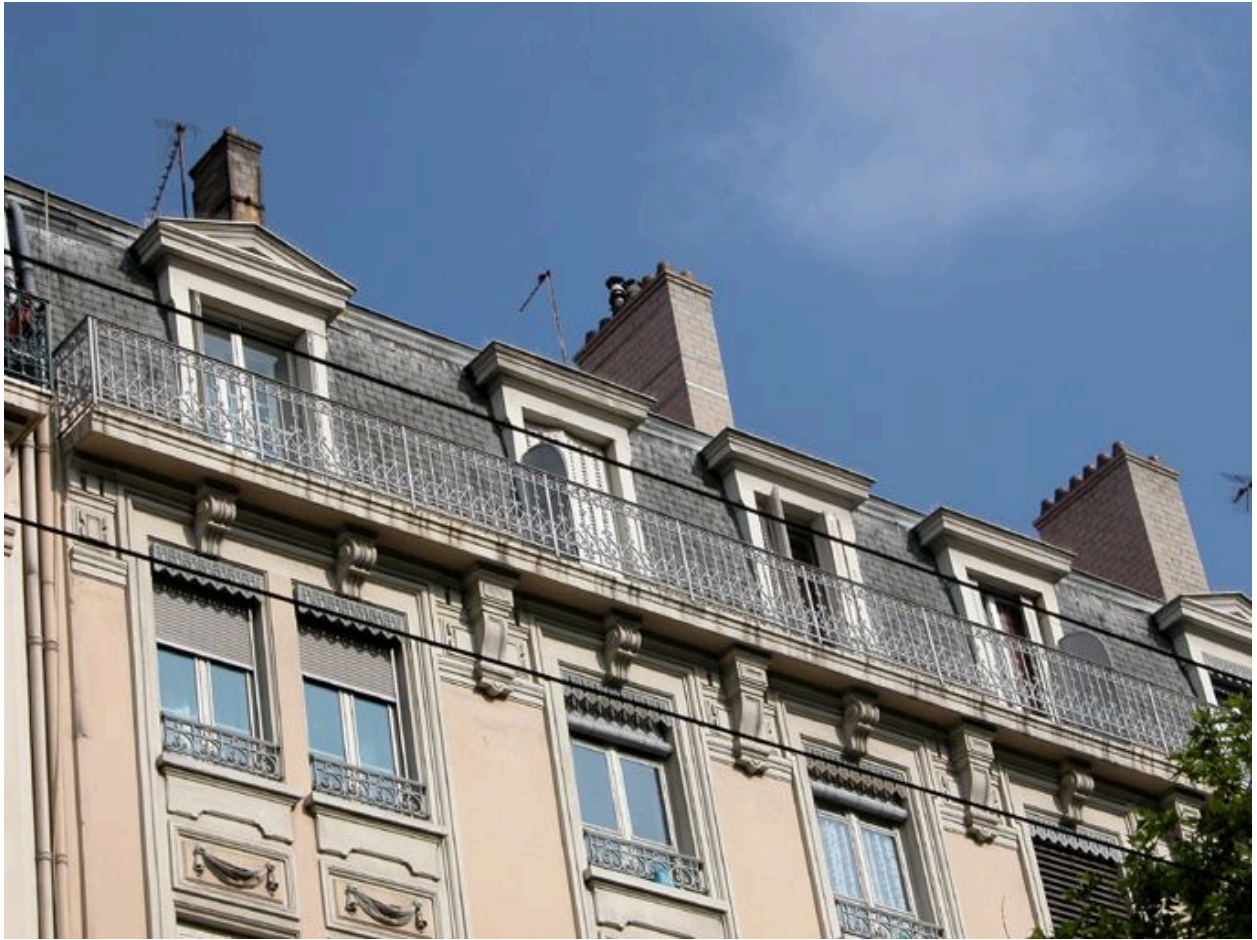
Vue du balcon filant de l'étage de comble
