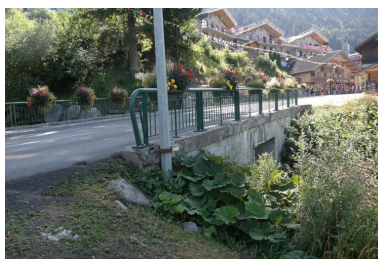
Vue générale du pont de Fiolle Phot. Pascale Renard IVR84_20197401202NUCA
