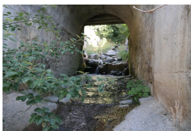
Pont de Fiolle, vue de dessous Phot. Pascale Renard IVR84_20207400944NUCA
