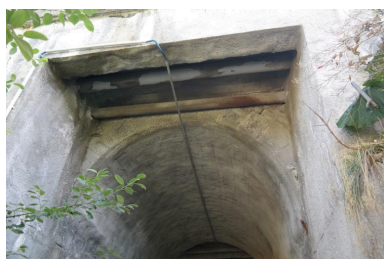
Pont de Fiolle, face aval Phot. Pascale Renard IVR84_20207400943NUCA
