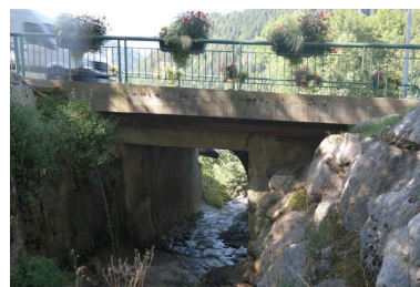
Pont de Fiolle, face amont Phot. Pascale Renard IVR84_20207400942NUCA
