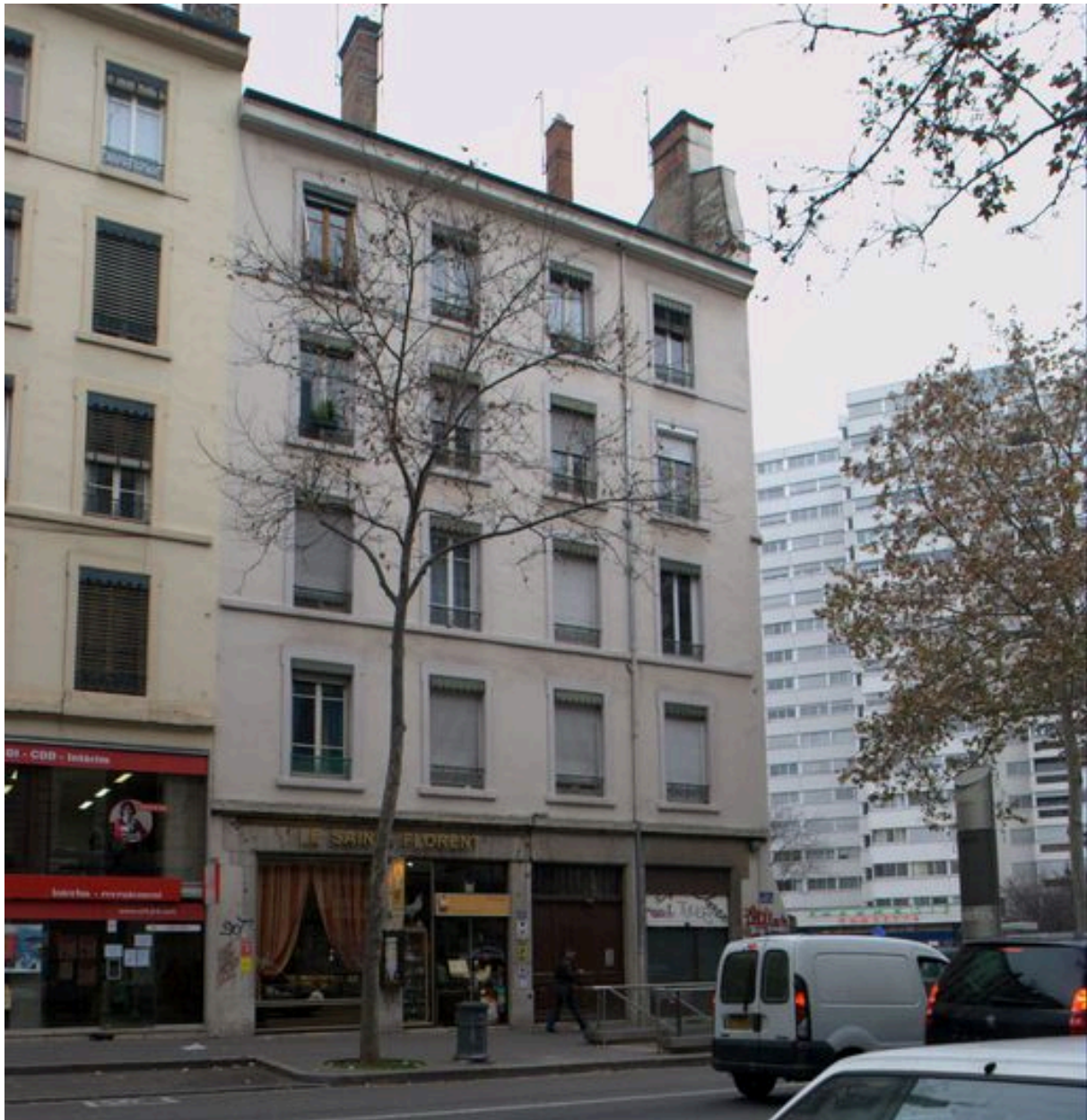
Elévation principale depuis le nord-est
