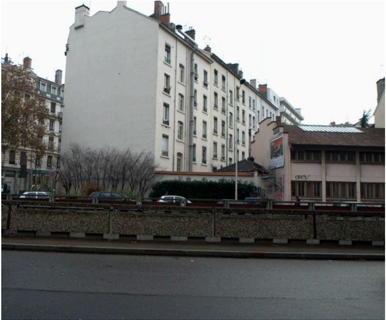
Élévation postérieure et latérale droite depuis le sud-ouest
