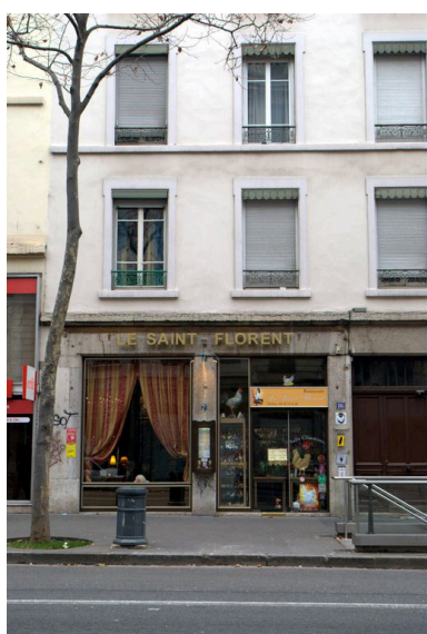
Détail de l'élévation principale Phot. Maryannick Chalabi IVR82_20086900728NUCA
