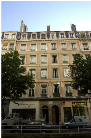
Façades, vue générale Phot. Bernard Ducouret IVR82_20046900972NUCA
