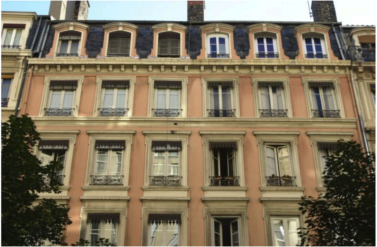
Façade, partie supérieure
