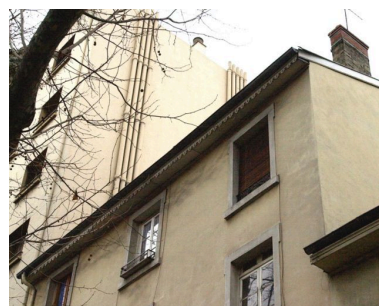
Détail de la rive de toit en bois découpé Phot. Maryannick Chalabi IVR82_20016900140NUCA
