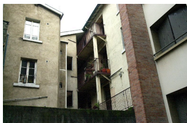
Élévation postérieure, vue des coursiers Phot. Maryannick Chalabi IVR82_20016900143NUCA
