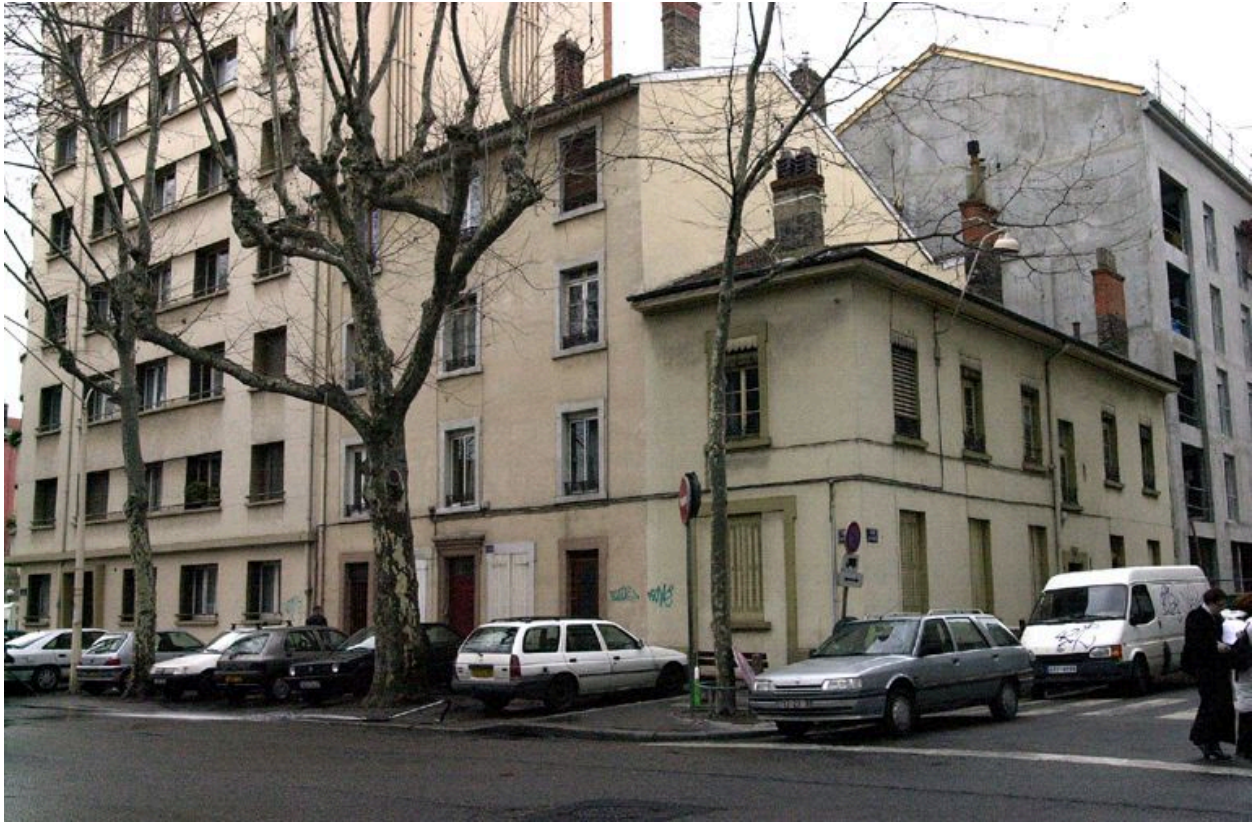
Vue générale depuis le nord-ouest
