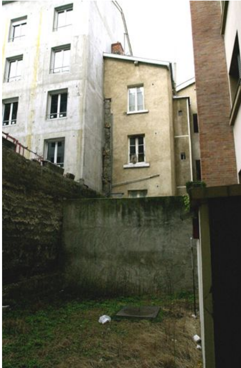
Vue du corps de bâtiment sur cour
