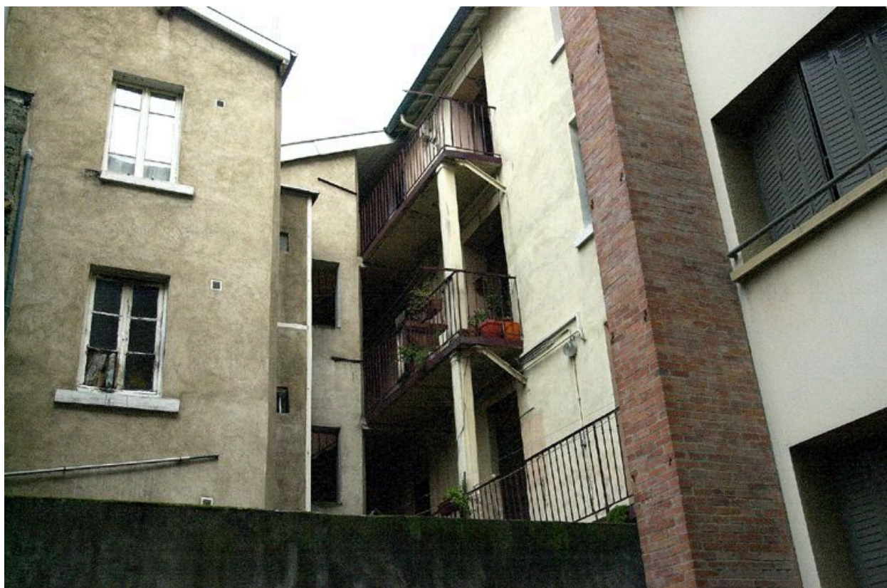
Élévation postérieure, vue des coursières
