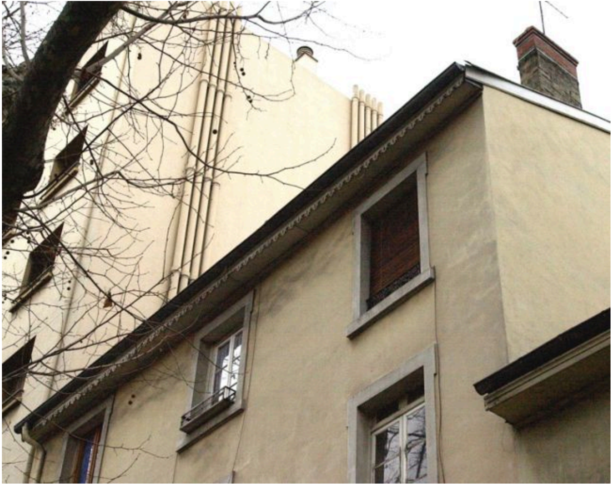
Détail de la rive de toit en bois découpé
