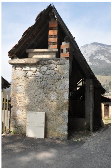
Vue sud-est Phot. Yannick Milleret IVR82_20107300844NUCA
