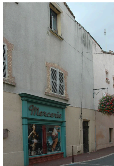
Vue partielle de l'élévation latérale, porte piétonne donnant sur l'ancienne venelle. Phot. Simone Hartmann-Nussbaum IVR82_20134200575NUCA
