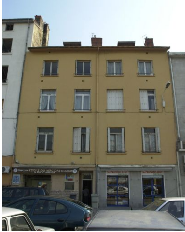
Elévation principale Phot. François Blanchetière IVR82_20016902008NUCA
