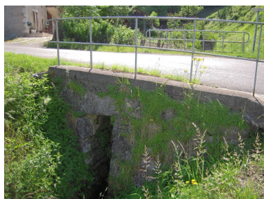
Pont au dessus du ruisseau du Cruet. Phot. Clémence Serve IVR82_20117403550NUCA
