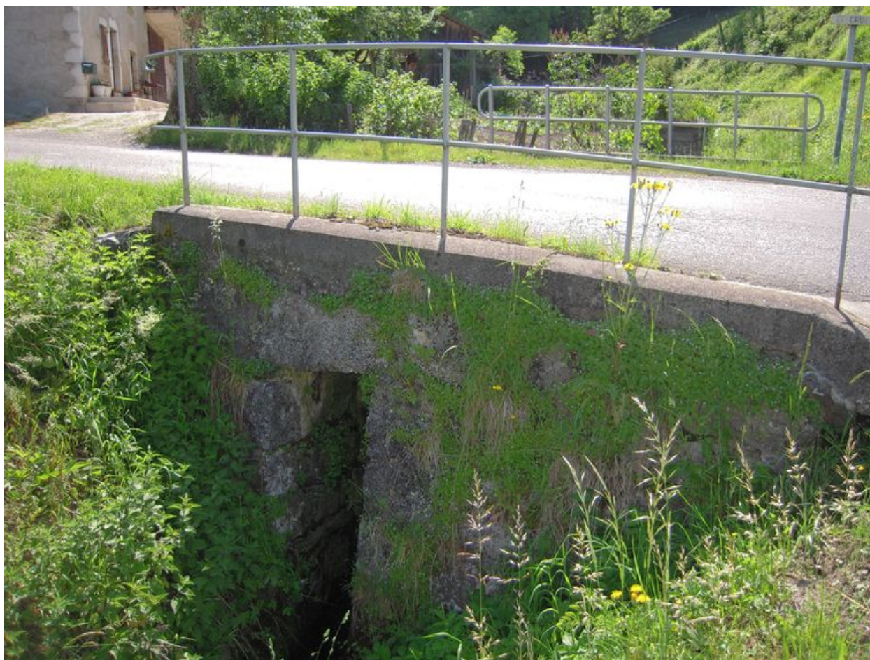
Pont au dessus du ruisseau du Cruet.
