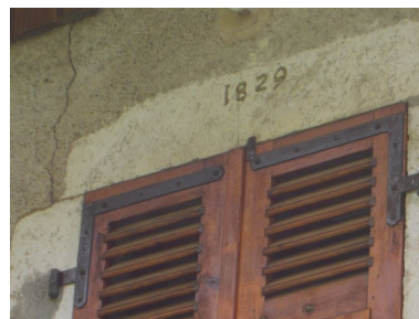
Inscription sur une ancienne ferme réaménagée. Phot. Clémence Serve IVR82_20117403582NUCA
