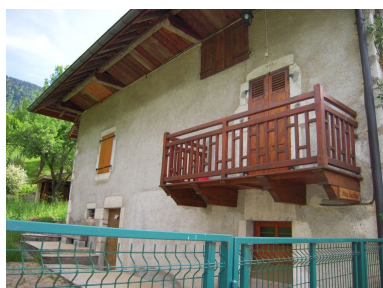
Maison d'habitation. Phot. Clémence Serve IVR82_20117403581NUCA
