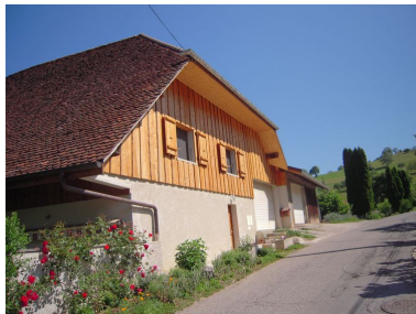
Mur pignon d'une ancienne ferme réaménagée en maison d'habitation. Phot. Clémence Serve IVR82_20117403553NUCA
