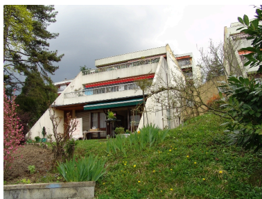
Façade principale de l'immeuble nord Phot. François Fouger IVR82_20077300253NUCA
