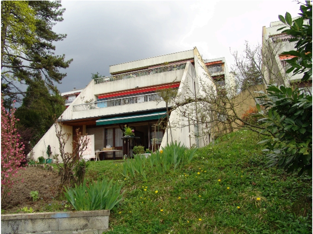
Façade principale de l'immeuble nord
