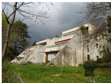
Vue d'ensemble Phot. François Fouger IVR82_20077300252NUCA
