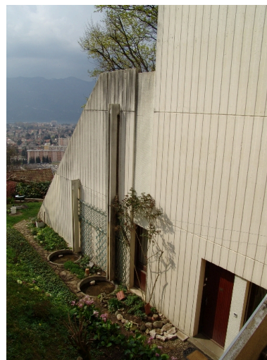
Elévation sud de l'immeuble nord Phot. François Fouger IVR82_20077300251NUCA
