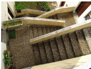
Escalier extérieur Phot. François Fouger IVR82_20077300249NUCA
