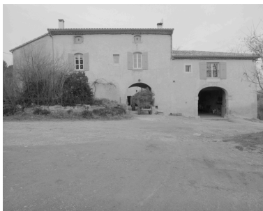
Élévation antérieure, au sud-ouest. Phot. Alain Franchella IVR82_19982601040X
