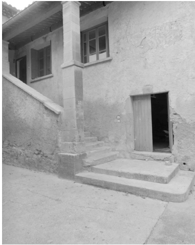
L'escalier conduisant au logis à l'étage. Phot. Alain Franchella IVR82_19982601042X
