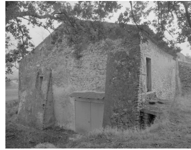
Une partie des dépendances, à l'extrémité nord-est. Phot. Alain Franchella IVR82_19982601038X
