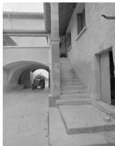
Les logis ancien et moderne, vus depuis la cour. Phot. Alain Franchella IVR82_19982601046X
