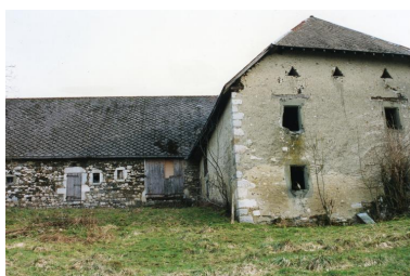
Vue d'ensemble depuis le nord-ouest : mur pignon du logement, revers de la grange-étale (vers 2000). IVR84_20167304625NUCAB
