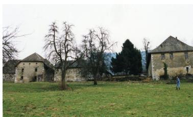
Vue générale depuis le nord-est. IVR84_20167304632NUCAB
