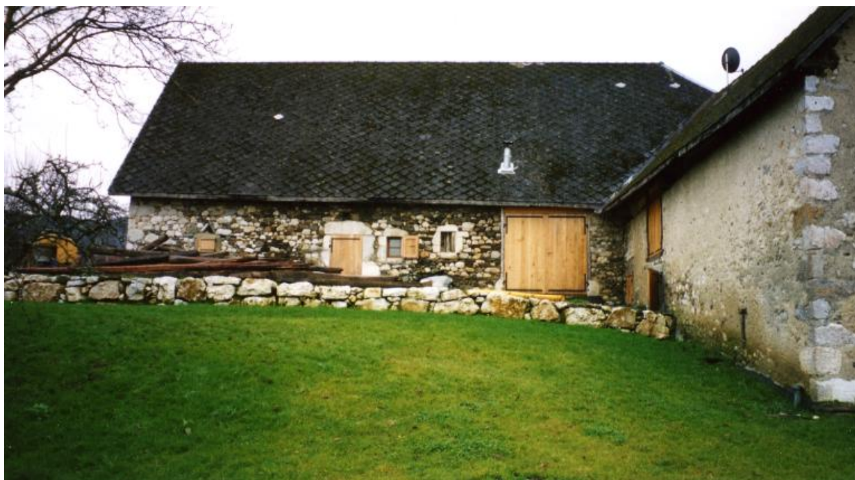
Vue d'ensemble depuis l'ouest : mur arrière du logement, revers de la grange-étable (vers 2000).
