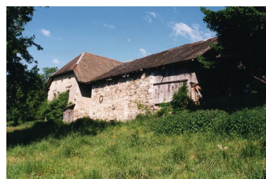
Vue d'ensemble depuis l'ouest : revers de la grange-remise, mur pignon de l'habitation (avant 2000). IVR84_20167304624NUCAB
