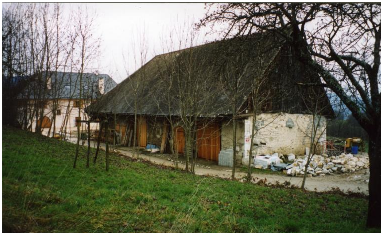
Vue d'ensemble depuis le nord : grange-étable. En arrière-plan, la maison de maître (vers 2003).
