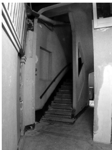
Escalier vu depuis la 1ère cour (actuellement cloisonnée et couverte) Phot. Bernard Ducouret IVR82_20046905879NUC
