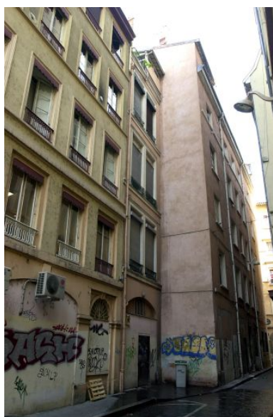
Façade sur la rue Valfènière Phot. Lore Derail IVR82_20036901345NUCA
