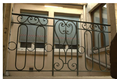
Escalier, détail du garde- corps du dernier palier donnant sur la première cour Phot. Lore Derail IVR82_20036901351NUCA
