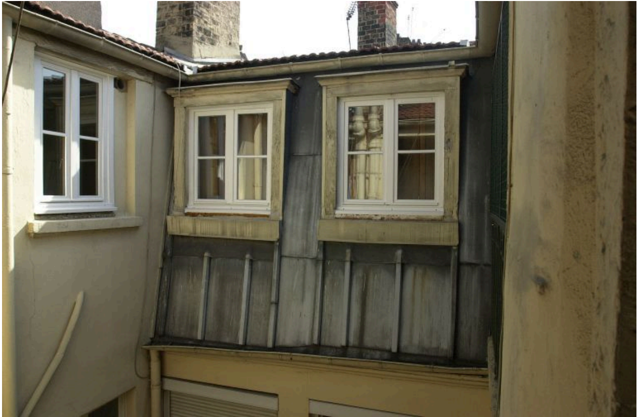
Deuxième corps de bâtiment, comble donnant sur la deuxième cour
