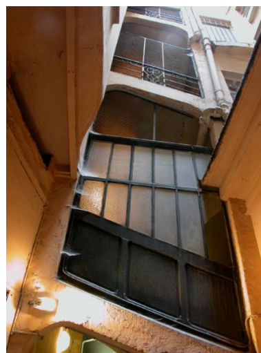
Elévation de la cage d'escalier sur la deuxième cour, partie inférieure Phot. Bernard Ducouret IVR82_20036901348NUCA
