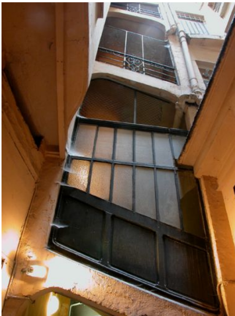
Elévation de la cage d'escalier sur la deuxième cour, partie inférieure
