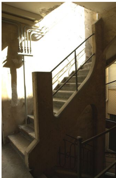
Escalier, montée vers les combles depuis le dernier le palier
