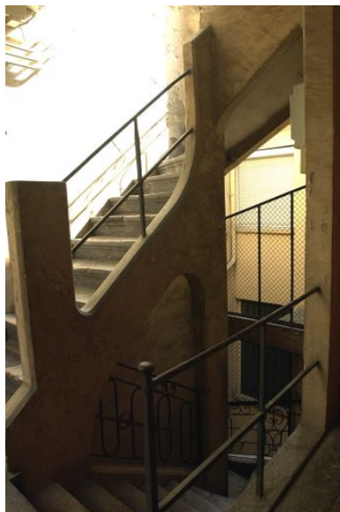
Escalier, dernier palier vu en direction de la deuxième cour
