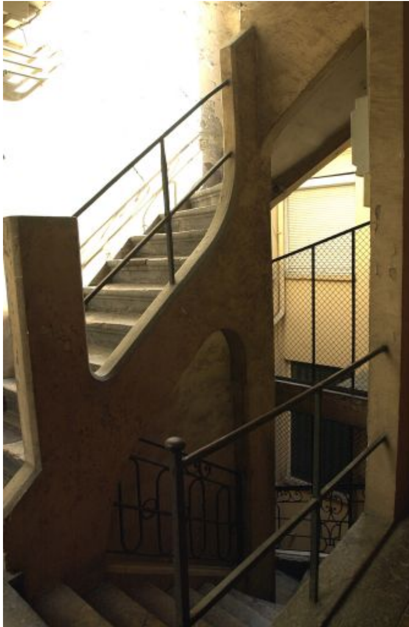
Escalier, dernier palier vu en direction de la deuxième cour
