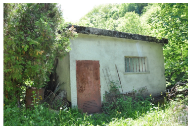
Vue d'un des bâtiments présents sur le site et abritant du matériel pour produire de l'électricité Phot. Yannick Milleret IVR82_20127301741NUCA
