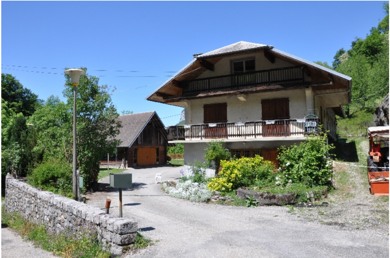
Vue d'un des bâtiments présents sur le site
