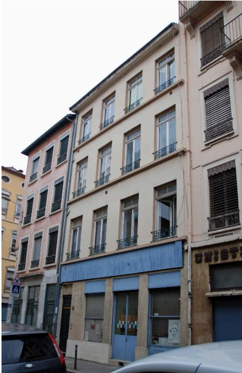
Vue générale, élévation sur rue
