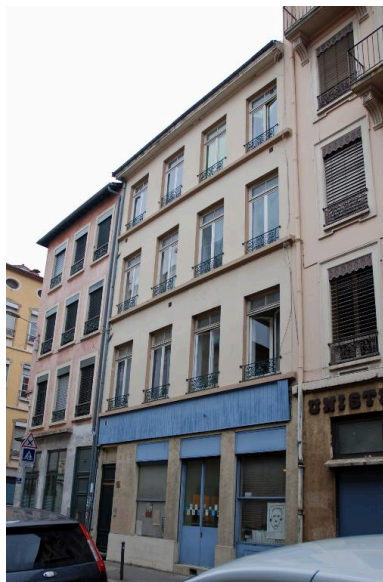
Vue générale, élévation sur rue Phot. Magali Delavenne IVR84_20166902268NUCA
