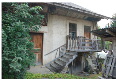
Vue du bâtiment annexe. Phot. Thierry Monnet IVR84_20187301256NUCA
