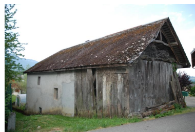
Vue arrière du bâtiment annexe. Phot. Thierry Monnet IVR84_20187301257NUCA
