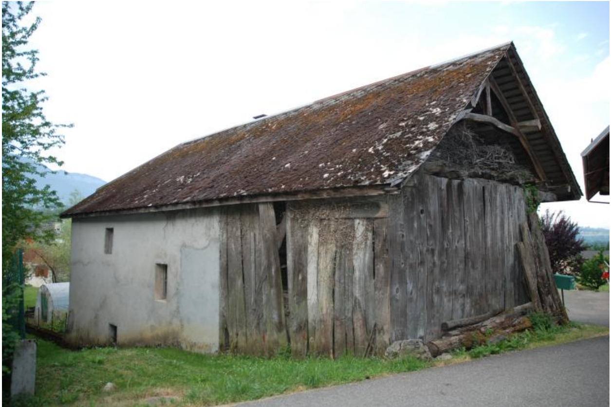
Vue arrière du bâtiment annexe.
