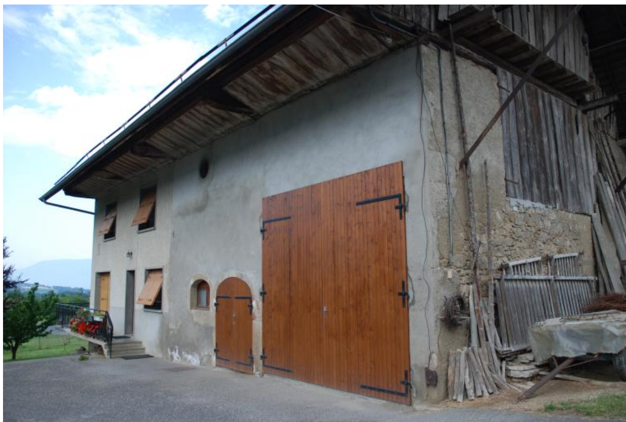
Vue d'ensemble du bâtiment principal.
