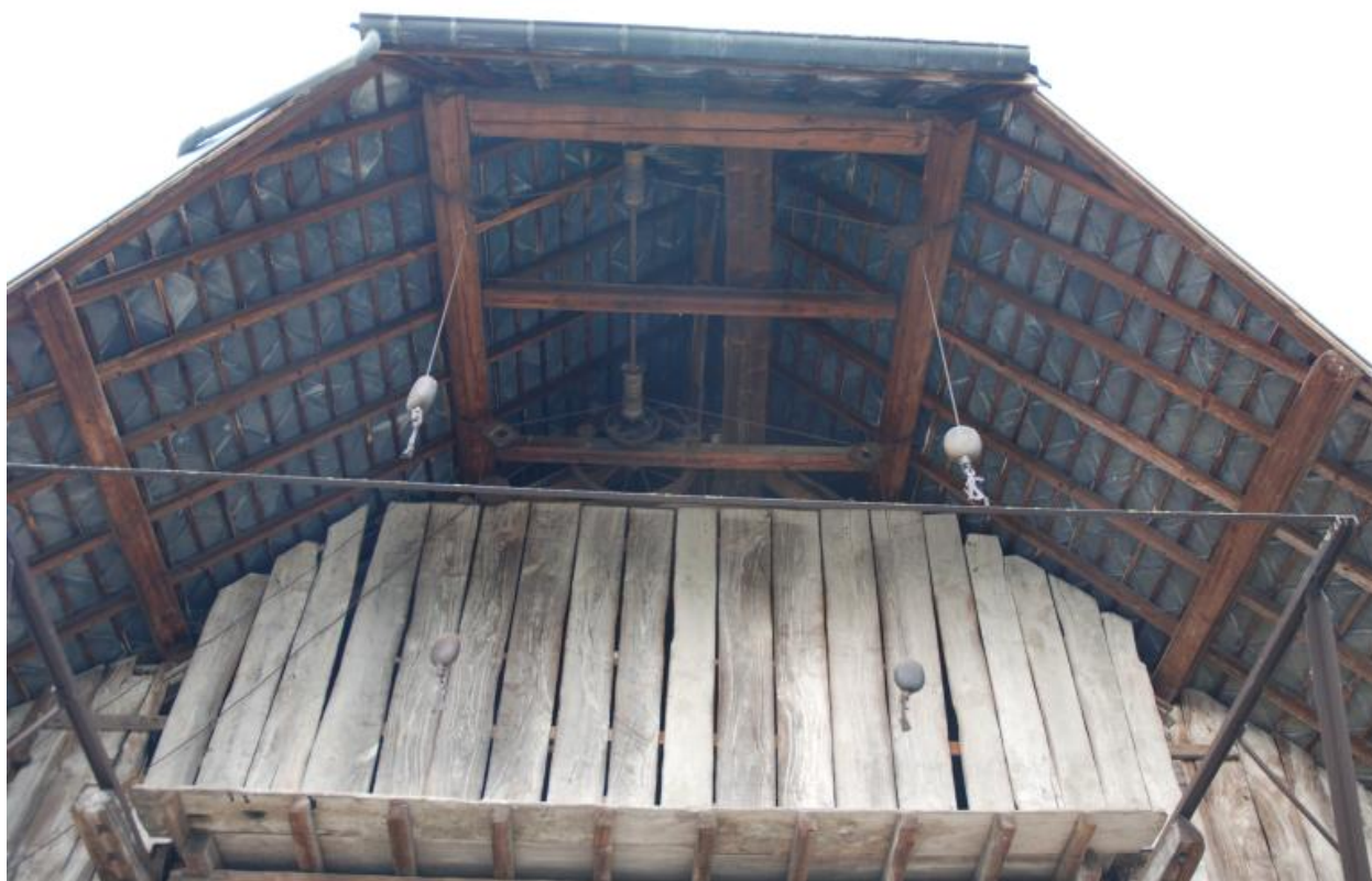
Vue du mur pignon du bâtiment principal : détail du treuil à foin et de l'entrée du fenil.
