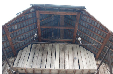
Vue du mur pignon du bâtiment principal : détail du treuil à foin et de l'entrée du fenil. Phot. Thierry Monnet IVR84_20187301252NUCA
