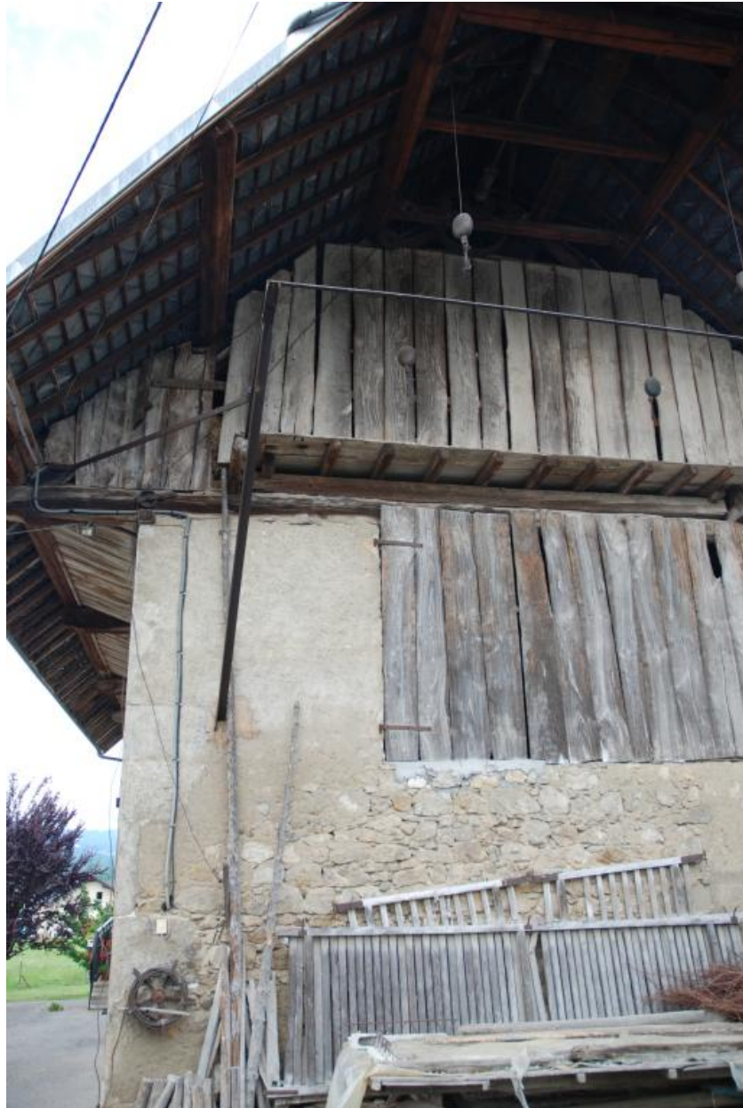
Vue du mur pignon du bâtiment principal.
