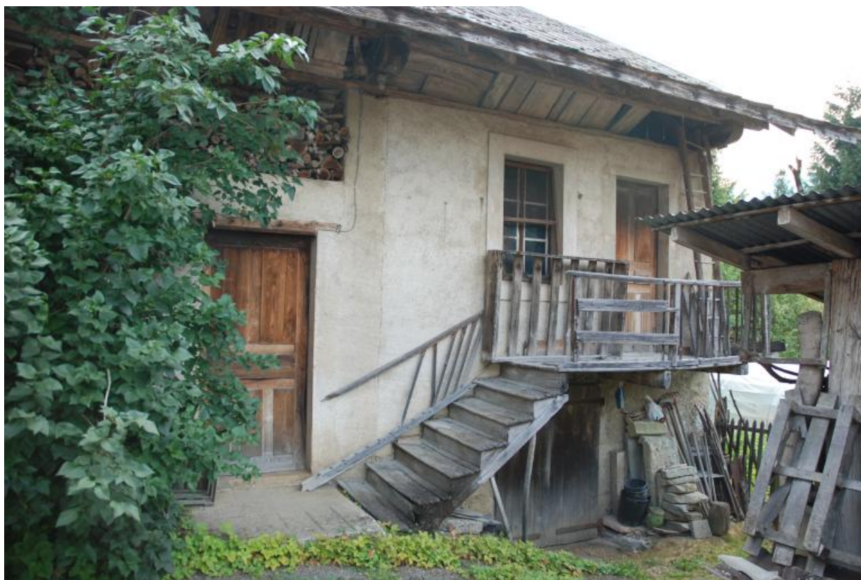
Vue du bâtiment annexe.
