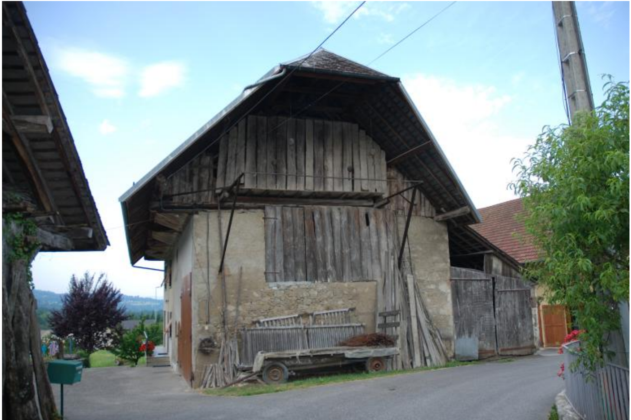
Vue du mur pignon du bâtiment principal.
