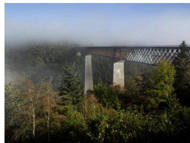
Le viaduc des Fades, à hauteur de tablier.
