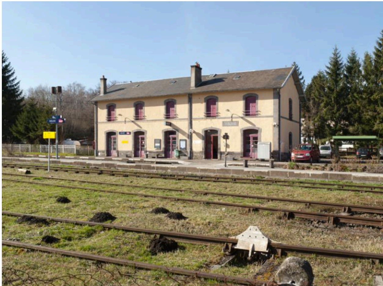
La gare de Volvic, implantée à quelque distance du bourg lui-même, côté sud-ouest.
