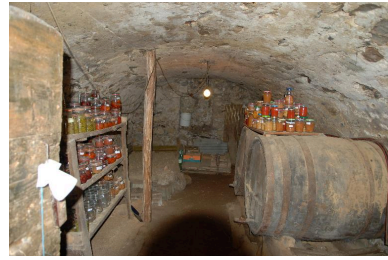
Vue intérieure de la cave voûtée. Phot. Thierry Monnet IVR84_20177300734NUCA
