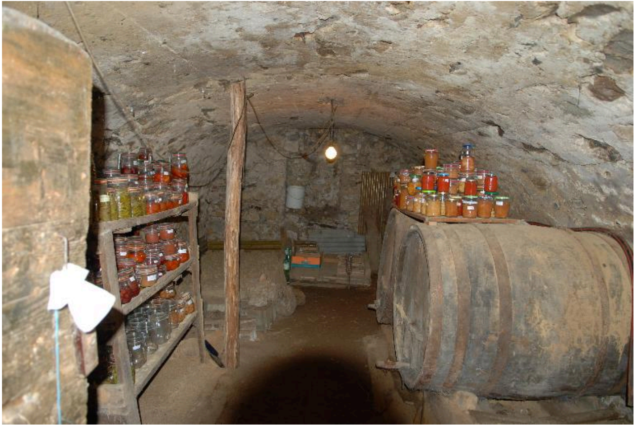
Vue intérieure de la cave voûtée.
