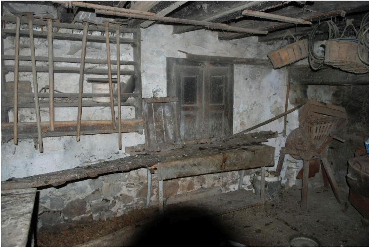
Vue intérieure de la cuisine avec placard mural.
