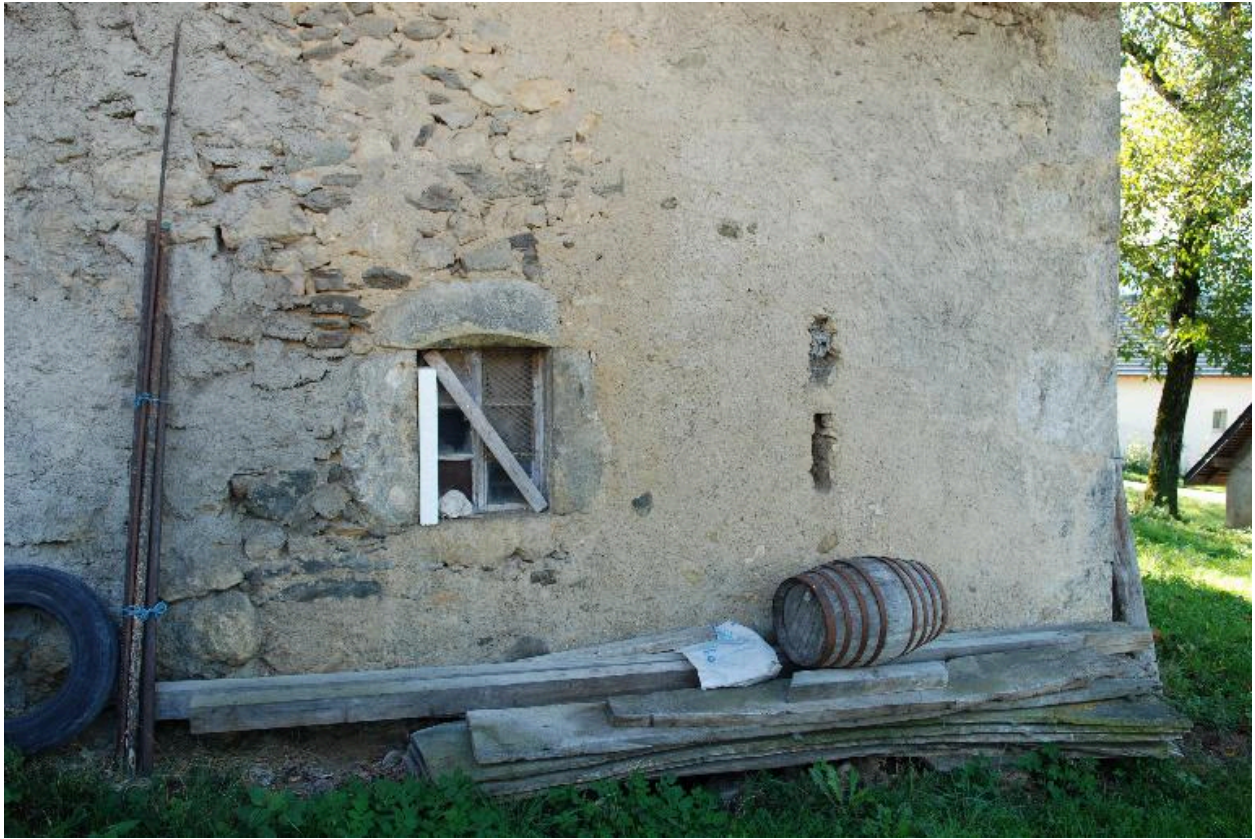
Vue façade arrière, détail des jours extérieurs de placard.
