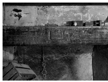
Cheminée de la cuisine, détail de la date sur le linteau. Phot. Thierry Leroy IVR82_20157303722NUCQ
