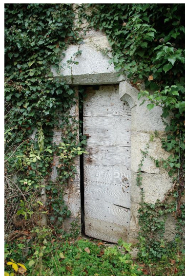
Remise de la ferme, porte en remploi. Phot. Thierry Monnet IVR84_20177301930NUCA
