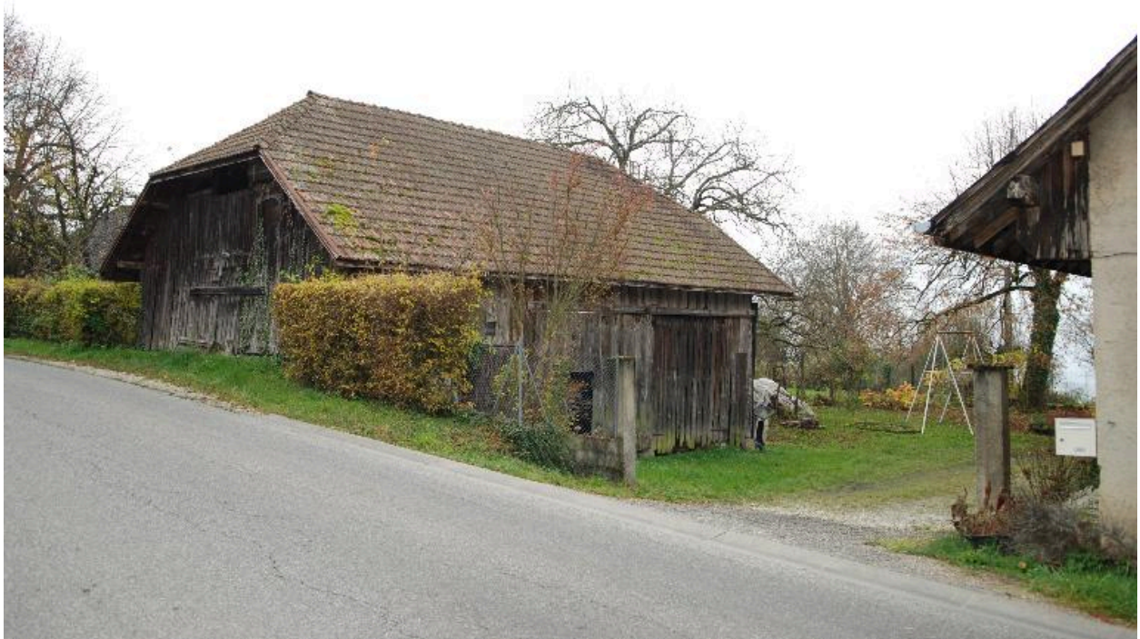
Vue d'ensemble d'un hangar de la ferme.
