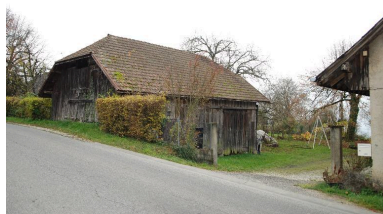
Vue d'ensemble d'un hangar de la ferme. Phot. Thierry Monnet IVR84_20177301931NUCA
