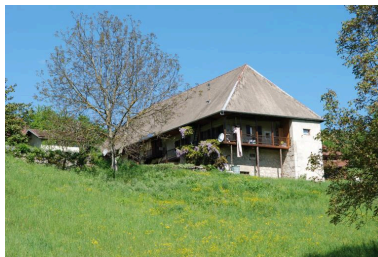
Vue d'ensemble de la ferme. Phot. Thierry Monnet IVR84_20187400363NUCA
