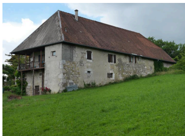
Vue d'ensemble de trois- quarts arrière gauche Phot. Thierry Leroy IVR82_20157402611NUCAQ
