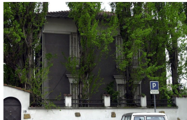
Vue rapprochée de la façade sur rue Phot. Véronique Belle IVR82_20016901513NUCA
