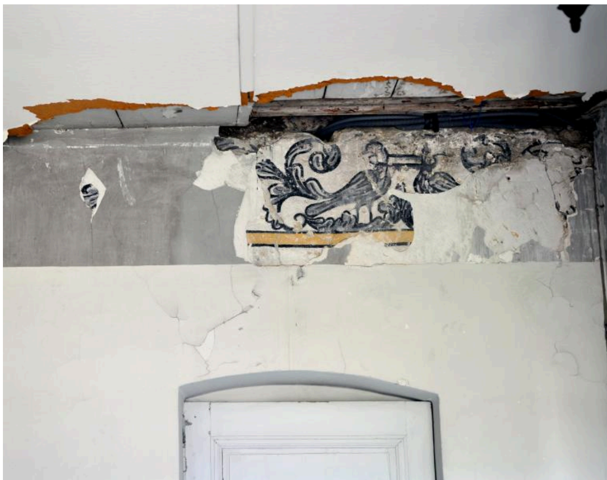
Mur nord : détail du décor peint sous-jacent
