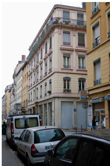
Elévation ouest, rue Sébastien-Gryphe Phot. Magali Delavenne IVR84_20166902285NUCA
