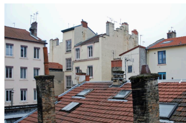
Elévation postérieure, vue lointaine Phot. Magali Delavenne IVR84_20166902293NUCA
