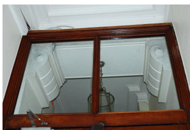
Détail : imposte de la porte du vestibule-sas et consoles Phot. Magali Delavenne IVR84_20166902290NUCA
