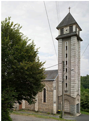
Vue générale du clocher.
