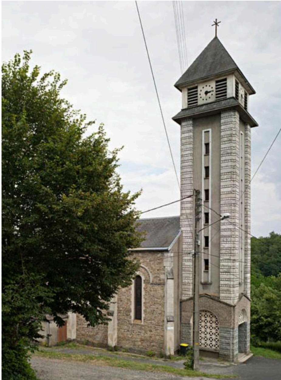
Vue générale du clocher.
