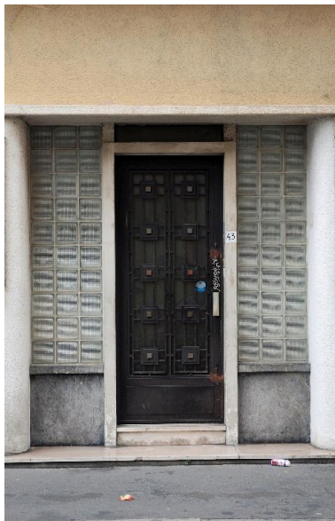
Porte d'entrée Phot. Magali Delavenne IVR84_20166901934NUCA
