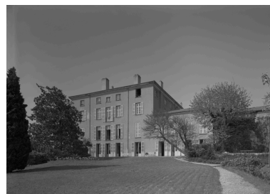
Façade sur jardin. Phot. Eric Dessert IVR82_19910100529P
