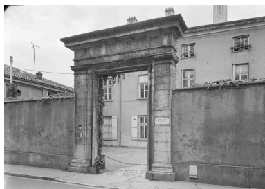
Portail sur rue. Phot. Jean-Marie Refflé IVR82_19910100641P
