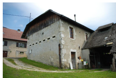
Vue de la fruitière depuis le nord-ouest : accès à la cave, aérations de la salle de refroidissement du lait. Phot. Thierry Monnet IVR82_20147302320NUCA
