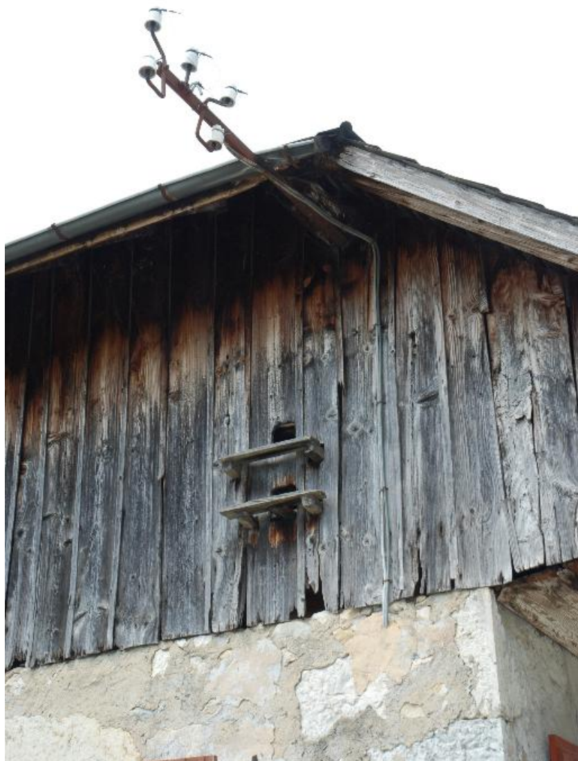
Détail du pignon sud de l'habitation : pigeonnier.
