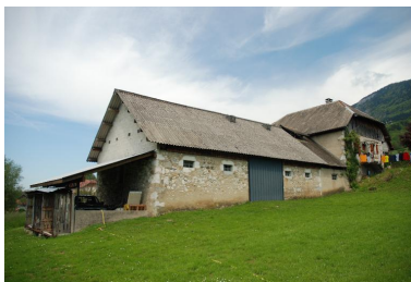
Vue d'ensemble de la porcherie, face sud. Phot. Thierry Monnet IVR82_20147302322NUCA
