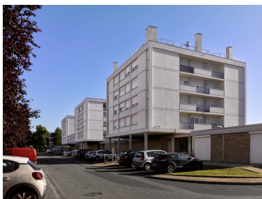
Ensemble des trois petites "tours" du centre de la cité, côté ouest. Phot. Christian Parisey IVR84_20206300932NUC4A
