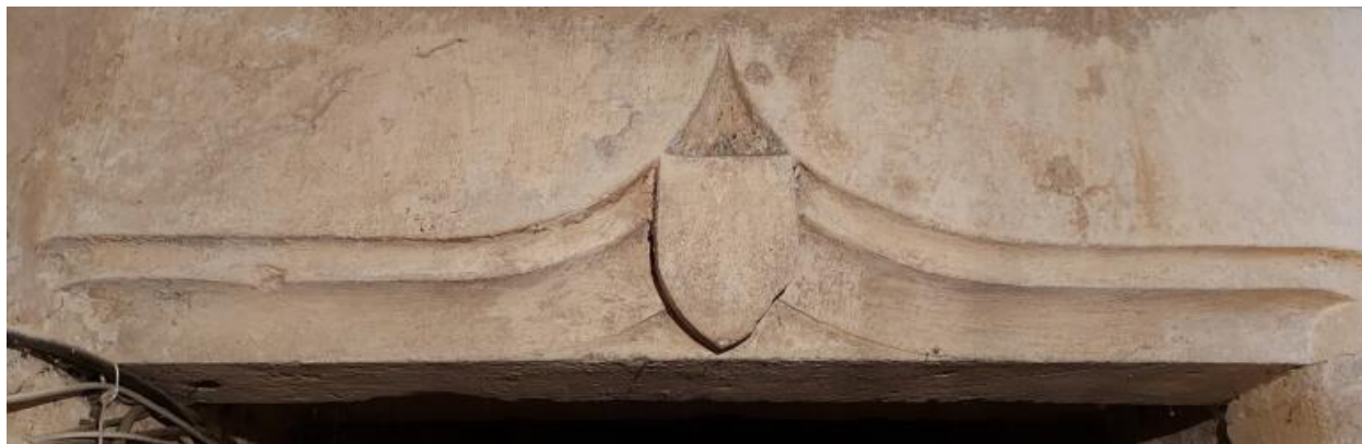
Ecusson sous un arc en accolade (dessus de porte d'accès à l'escalier)
