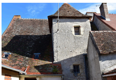
Détail de la tour d'escalier au sud. Phot. Maryse Durin-Tercelin IVR84_20250300567NUC4A
