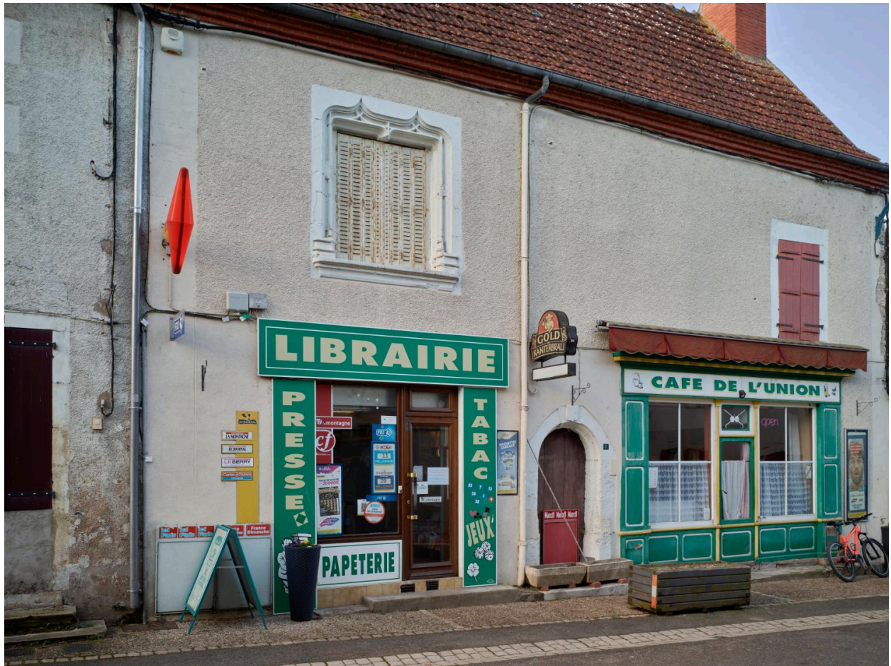
Vue générale de l'édifice, façade sur rue, au nord.
