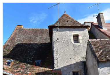
Détail de la tour d'escalier au sud. Phot. Maryse Durin-Tercelin IVR84_20250300568NUC4A
