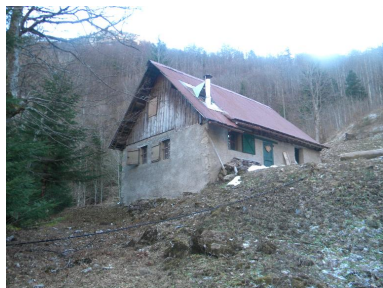
Vue de trois-quarts sud-ouest. Phot. Jérôme Daviet IVR84_20167306829NUCA
