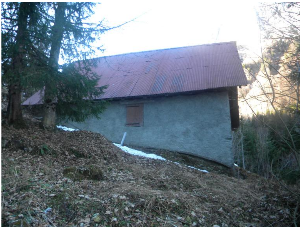
Vue de la façade arrière.
