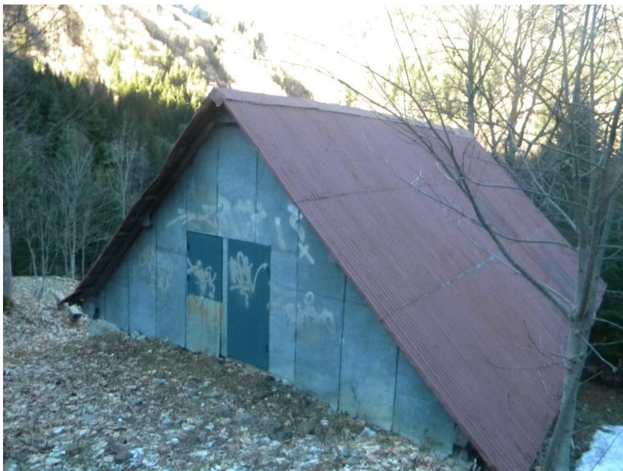
Vue du pignon est.
