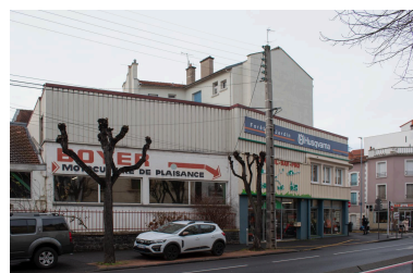
Elévation sur le boulevard Jean-Jaurès Phot. Félicie Fougère IVR84_20256300408NUCA
